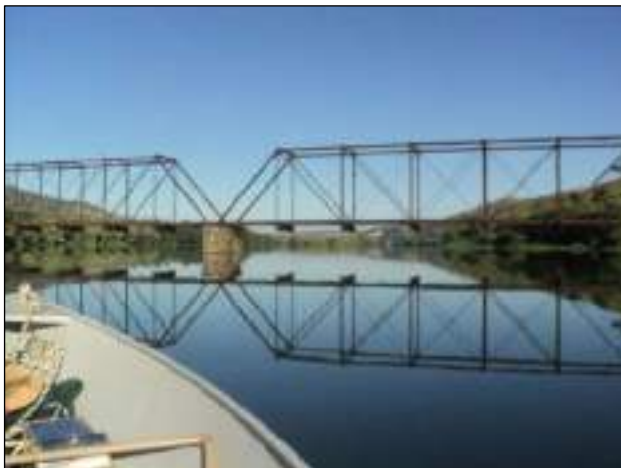
Figura 2: Montante do Ponto de Amostragem P00, localizado no reservatório da UHE Ilha dos Pombos, amostrados durante a execução do Programa.
