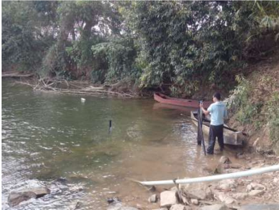
Figura 26 - Vista da manutenção dos primeiros lances de régua da estação limnimétrica de Itaocara I Eixo ME do rio Paraíba do Sul
