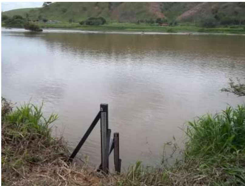
Figura 7 – Vista dos lances de réguas e seção de medição da estação hidrométrica de Jusante, no rio Paraíba do Sul.
