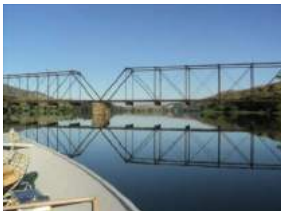
Figura 3: Montante do Ponto de Amostragem P00, localizado no reservatório da UHE Ilha dos Pombos, amostrados durante a execução do Programa.
