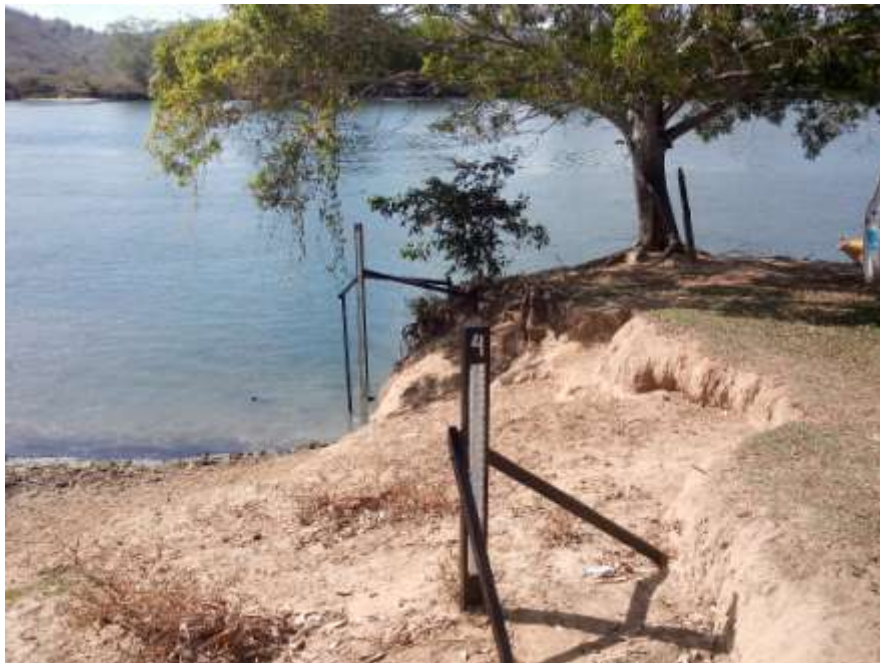
Vista dos primeiros lances de réguas da estação de Porto do Tuta
