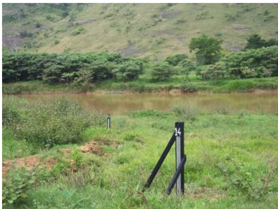
Vista geral dos lances de réguas da estação de Itaocara II Canal Esquerdo
