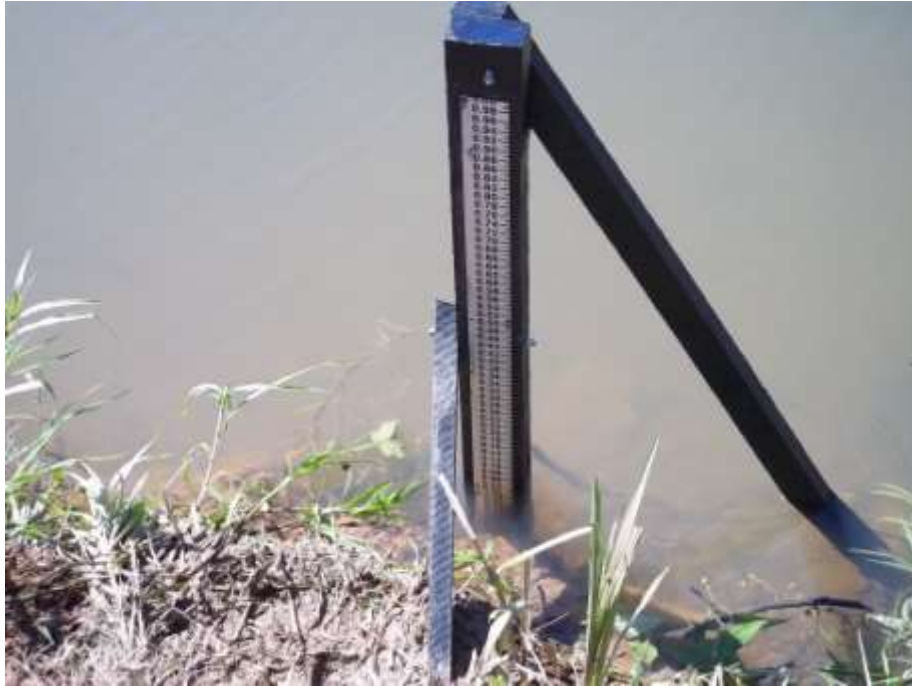
Figura 14 - - Manutenção do primeiro lance de régua da estação limnimétrica de Itaocara I Eixo MD no rio Paraíba do Sul
