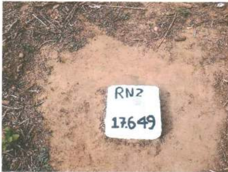
Figura 28 - Vista da manutenção da RN2 da estação limnimétrica de Itaocara I Eixo ME do rio Paraíba do Sul
