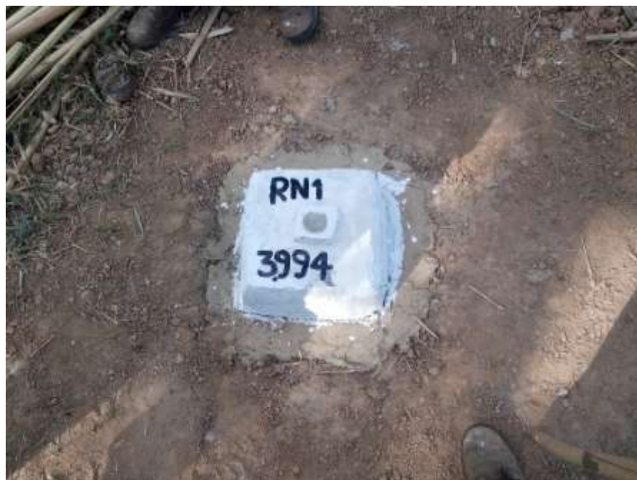
Figura 7 - Vista após a manutenção da RN1 da estação limnimétrica de Itaocara I Canal de Fuga ME no rio Paraíba do Sul.
