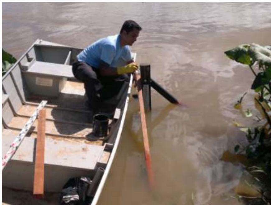
Foto 17 – Vista da complementação do lance 10/11 da estação Itaocara II Canal Direito MD no rio Paraíba do Sul.
