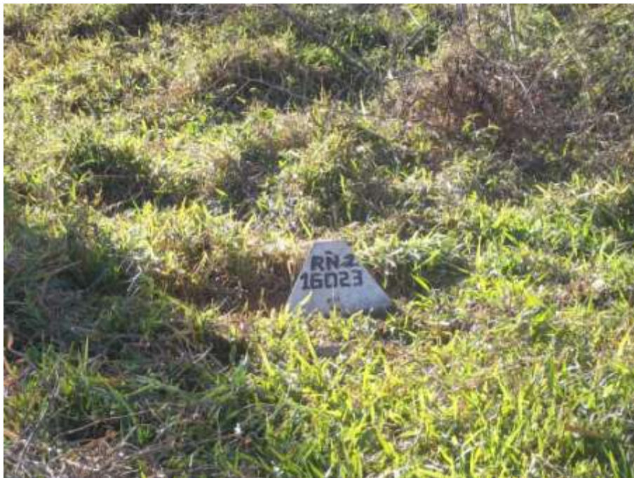
Figura 19 - Vista da RN1 após a manutenção da estação limnimétrica de Itaocara II Eixo ME do rio Paraíba do Sul
