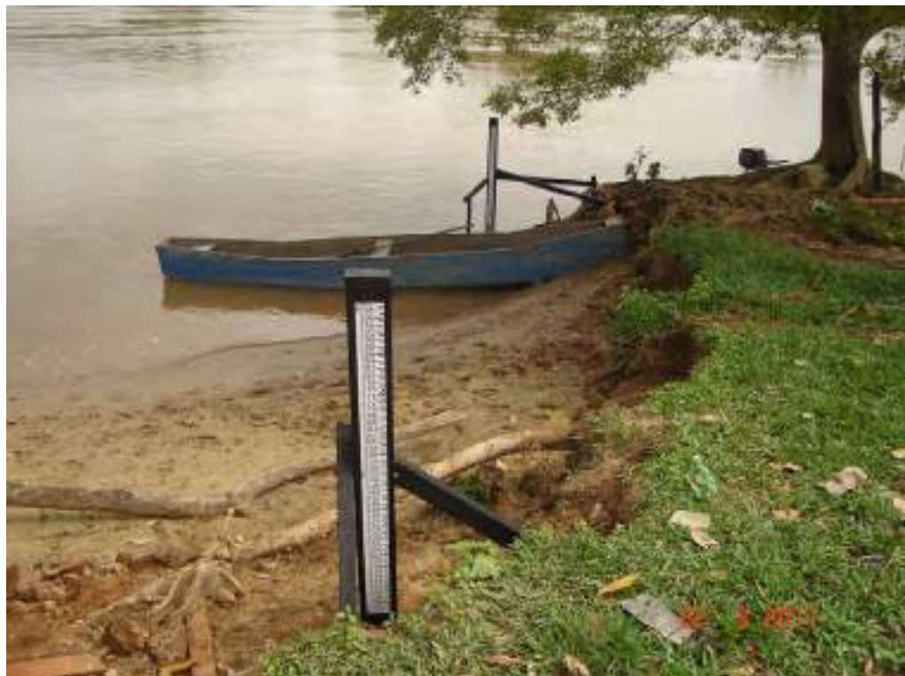
Foto 14 - Detalhe dos lances de réguas instalados na estação fluvio-sedimentométrica de Porto do Tuta no rio Paraíba do Sul.
