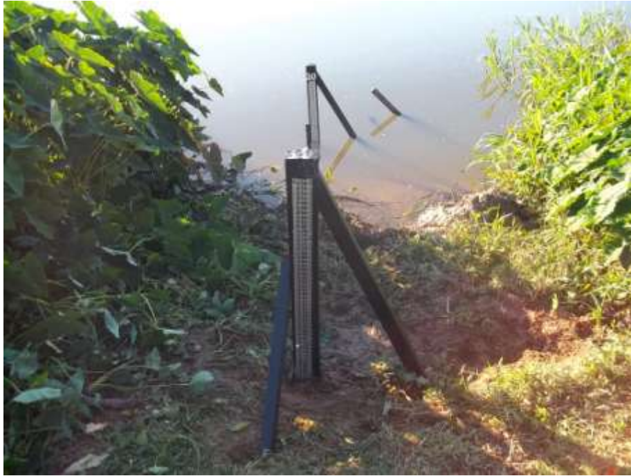
Figura 24 - Vista dos primeiros lances de régua 08/10 e 10/11 da estação limnimétrica de Itaocara II Eixo MD do rio Paraíba do Sul
