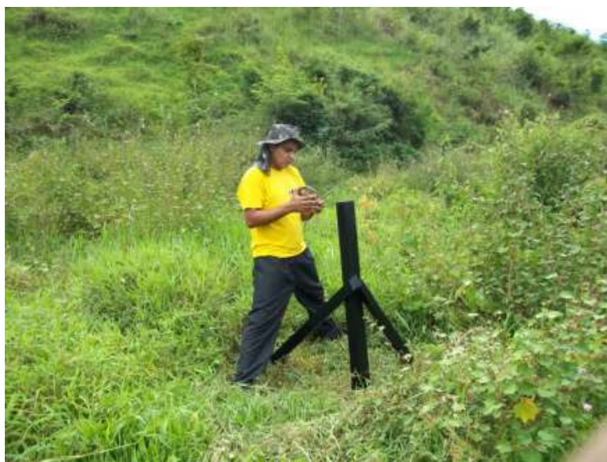
Foto 18 – Vista da manutenção e pintura do lance 13/14 da estação Itaocara II Canal Esquerdo no rio Paraíba do Sul.
