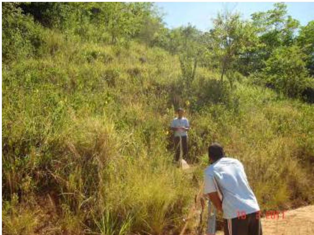
Foto 06 – Nivelamento para reinstalação das réguas destruídas pela enchente de janeiro na estação fluviométrica de Itaocara II no rio Paraíba do Sul.
