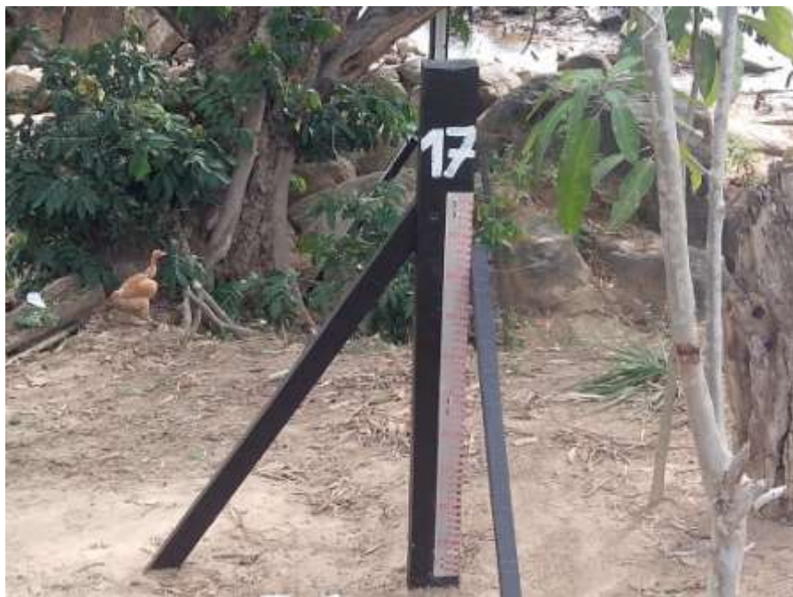
Figura 27 - Vista da manutenção do lance de régua 16/17 da estação limnimétrica de Itaocara I Eixo ME do rio Paraíba do Sul
