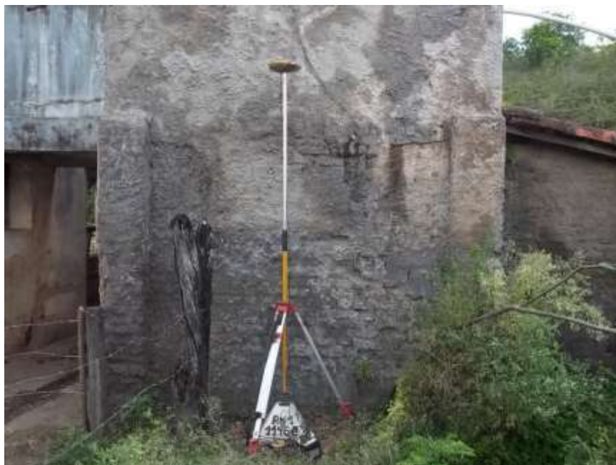
Foto 06 – Rastreamento com GPS da RN1 Itaocara I Montante para a RN1 da estação Itaocara I Canal de Fuga MD.
