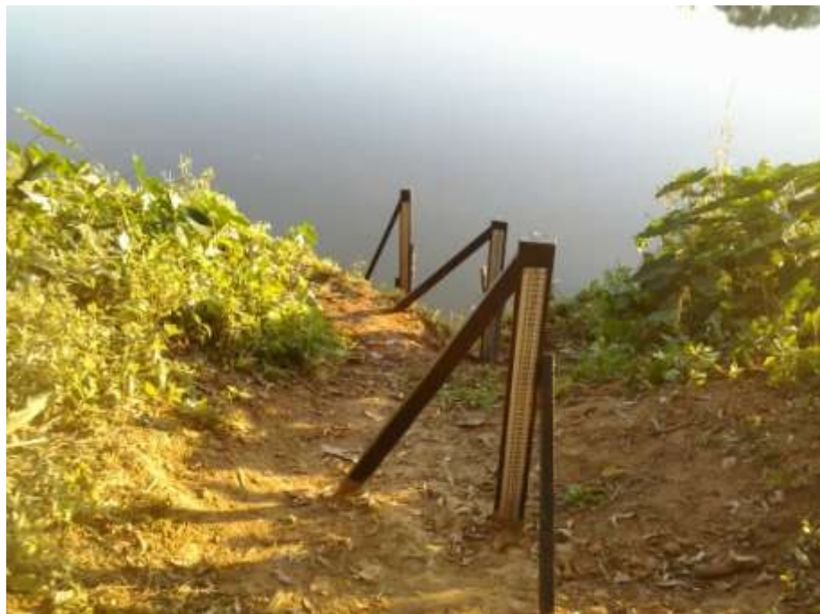
Figura 7 - Vista após a manutenção dos lances de régua da estação limnimétrica de Itaocara I Canal de Fuga ME no rio Paraíba do Sul.
