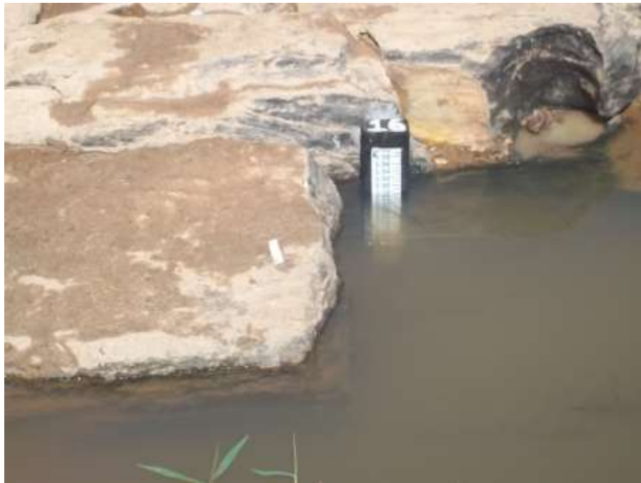
Figura 20 - Instalação de mais um lance de régua 15/17 na estação limnimétrica de Itaocara II Formiga Montante do rio Paraíba do Sul.
