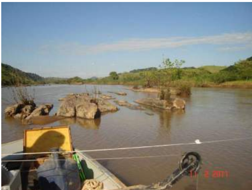
Foto 08 – Detalhe da interferência do afloramento rochoso na seção de medição da estação fluviométrica de Itaocara II Formiga Montante.
