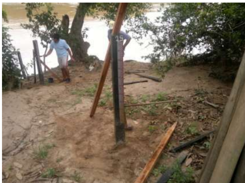
Foto 20 – Substituição, manutenção e pintura dos lances de réguas da estação Itacara II São Sebastião do Paraíba no rio Paraíba do Sul.
