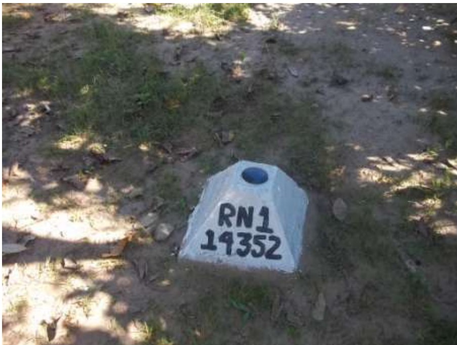
Figura 13 - Detalhe da manutenção da RN1 da estação limnimétrica de Itaocara II São Sebastião do Paraíba no rio Paraíba do Sul
