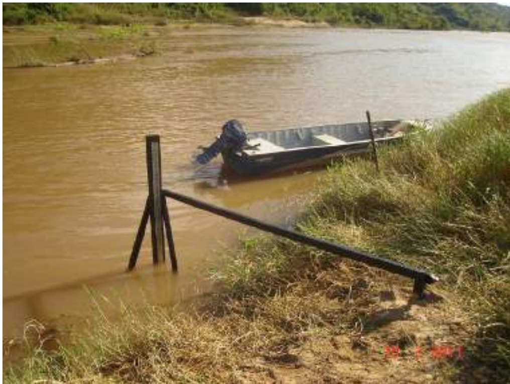
Foto 12 – Reinstalação do lance de réguas 16,00 a 18,00 da estação fluviométrica de Itaocara II Formiga Montante.
