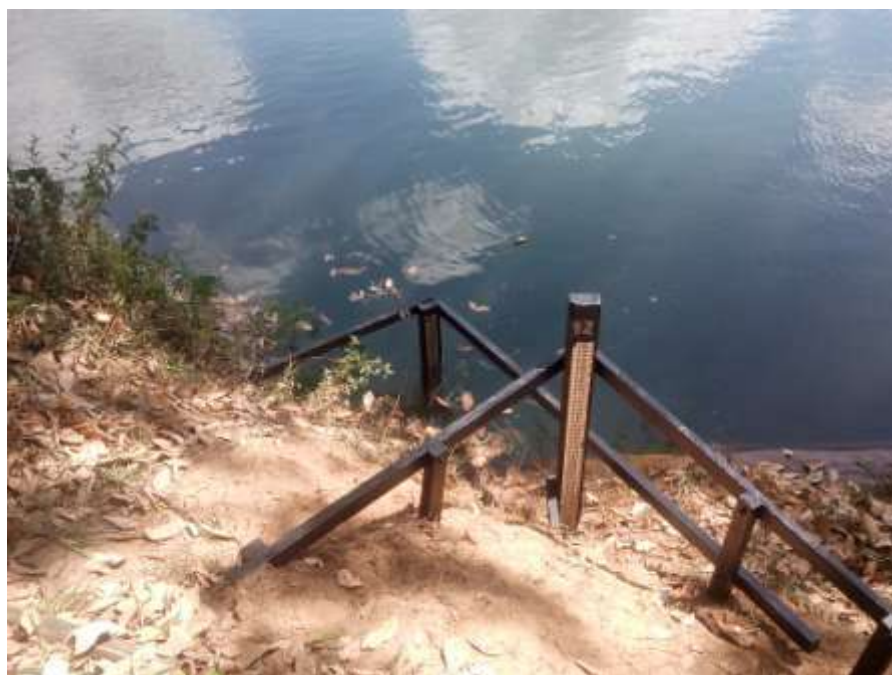
Figura 11 - Manutenção dos primeiros lances de régua da estação limnimétrica de Itaocara São Sebastião do Paraíba no rio Paraíba do Sul
