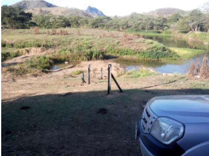
Vista geral dos lances de réguas da estação limnimétrica de Itaocara I Canal de Fuga MD no rio Paraíba do Sul.
