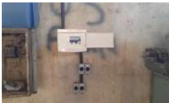
Reforma geral dos banheiros e revisão da parte elétrica e instalação de quadro geral de energia no polo de ensino em Itaocara RJ
