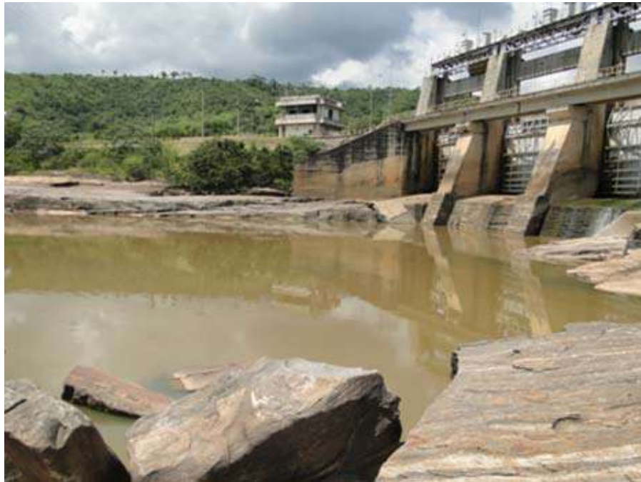
Figura 4. Área de amostragem localizada a jusante da escada de peixes da UHE Ilha dos Pombos (Ic 3). Data: 08/03/2013. Hora: 10:59.
