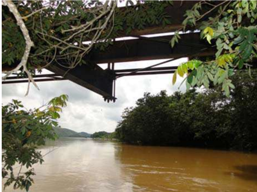
Figura 2. Área de amostragem localizada no reservatório da UHE Ilha dos Pombos (Ic 1). Data: 08/03/2013. Hora: 9:58.
