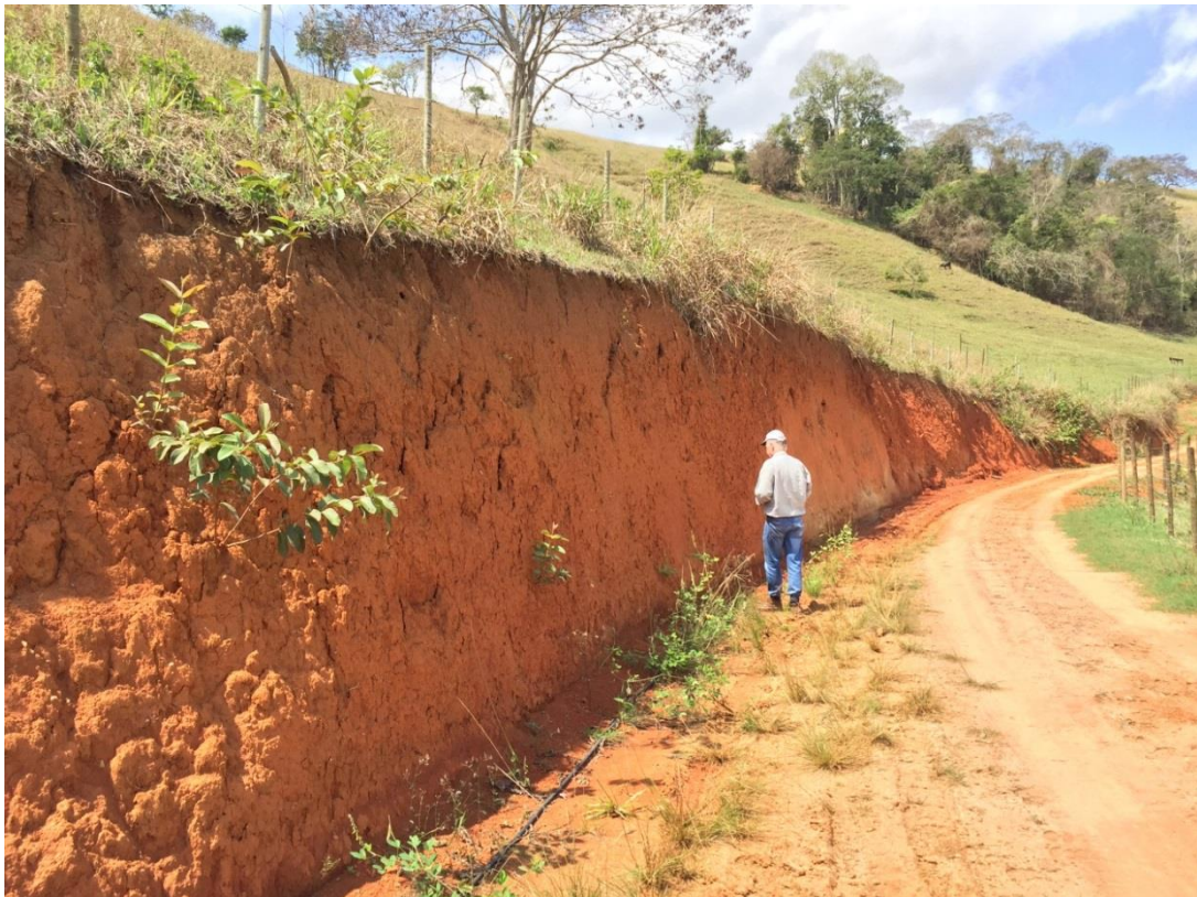
Figura 4.55 - Perfil de Material Coluvionar em Corte na Estrada da Margem Esquerda a Montante do Eixo do Barramento.
