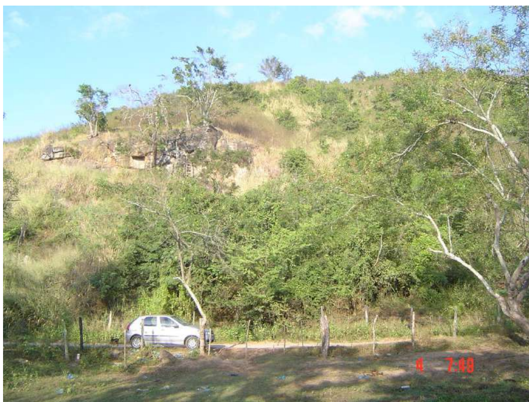
Foto 10 – Vista da ombreira direita. Notar afloramento de rocha.
