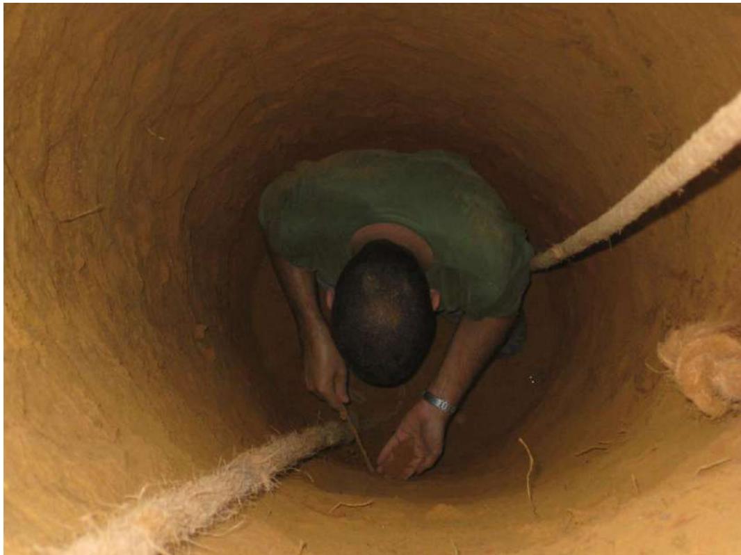
Foto 15 – Inspeção de poço (PEC-05) na margem esquerda.
