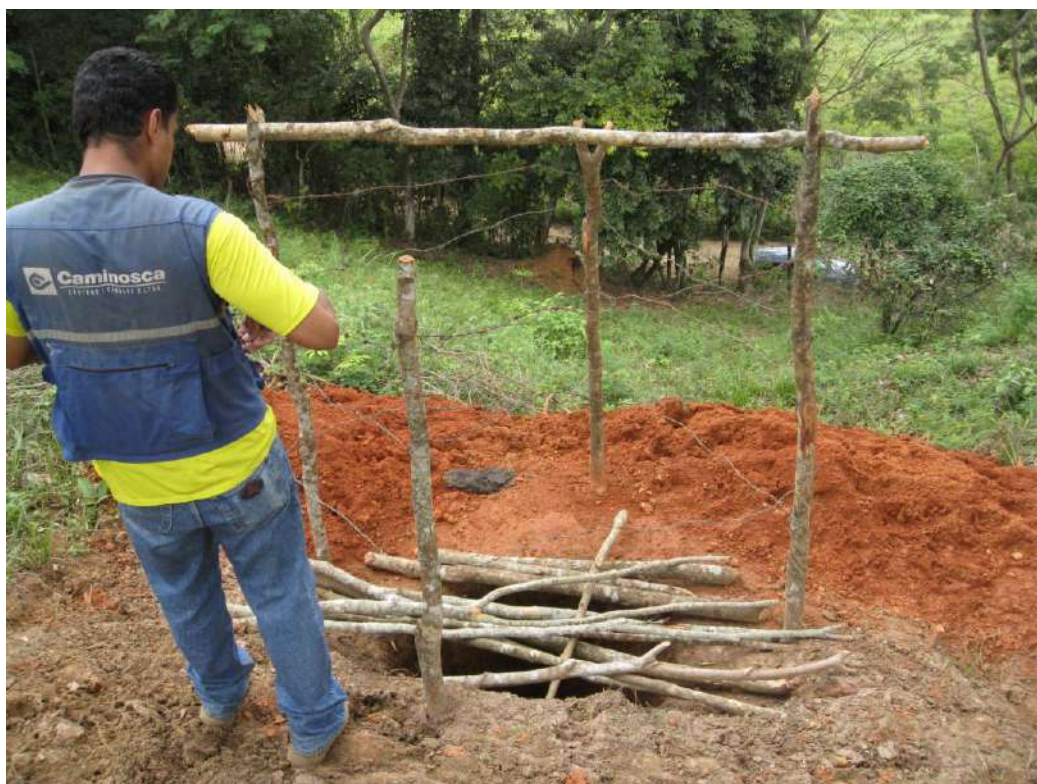
Foto 14 – Poço de Inspeção (PI-02) na margem esquerda.
