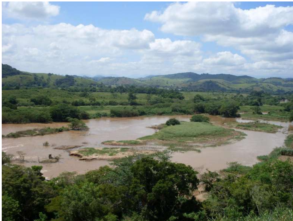
Foto 4 - Vista da margem direita para jusante na região do eixo.
