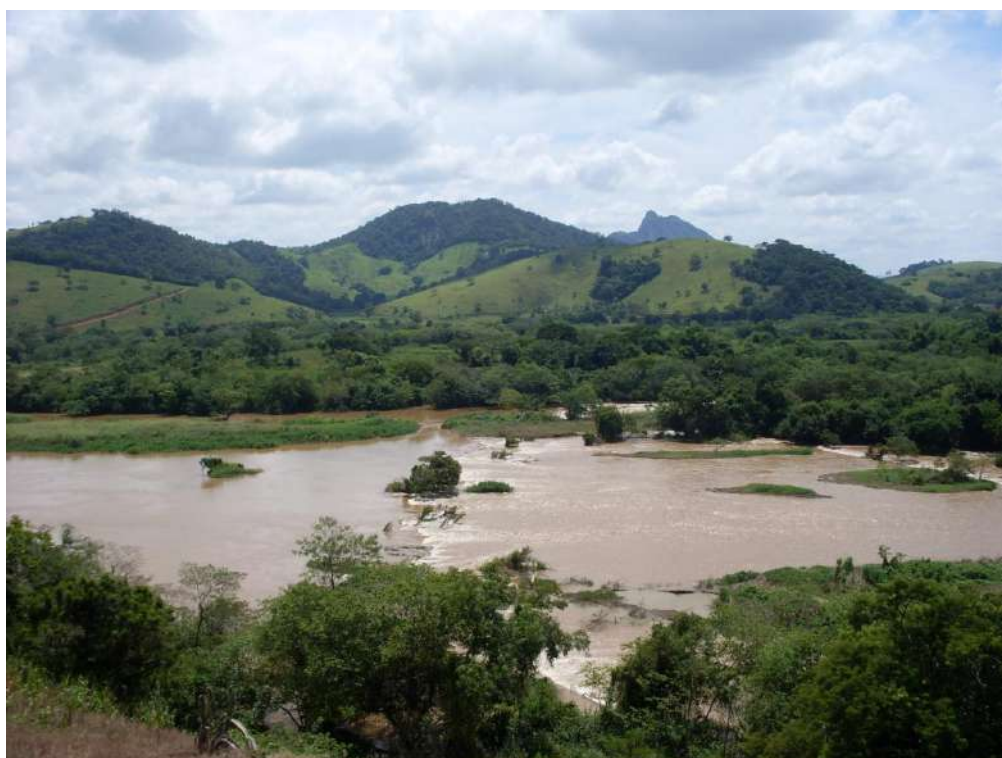
Foto 2 – Vista da margem direita para a margem esquerda no eixo do barramento.
