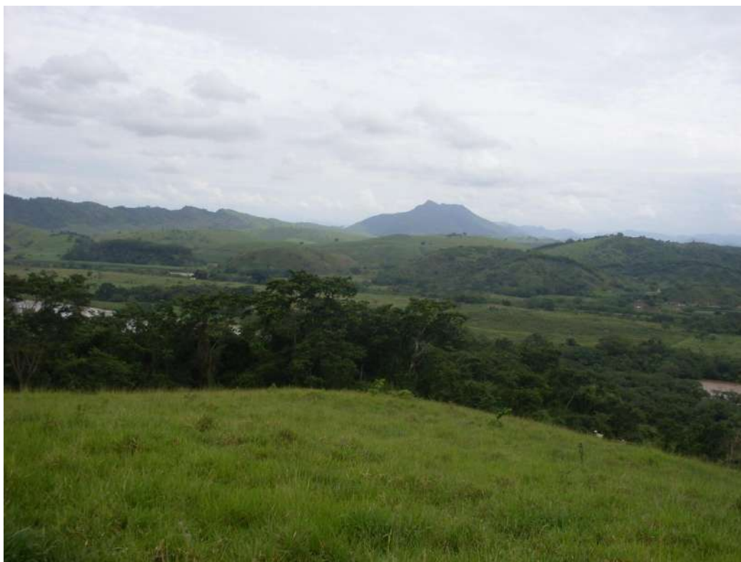
Foto 7 – Vista da margem esquerda para a margem direita no eixo do barramento.
