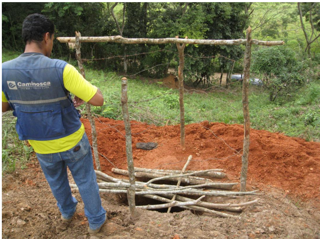
Foto 14 – Poço de Inspeção (PI-02) na margem esquerda.
