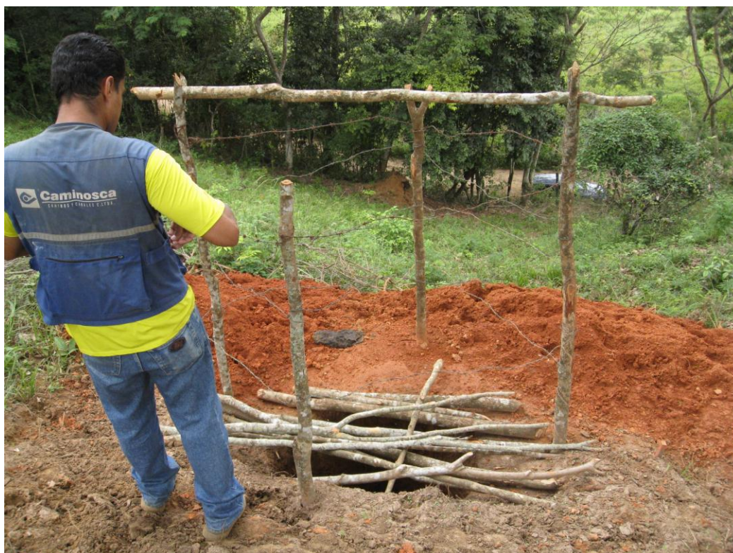
Foto 14 – Poço de Inspeção (PI-02) na margem esquerda.
