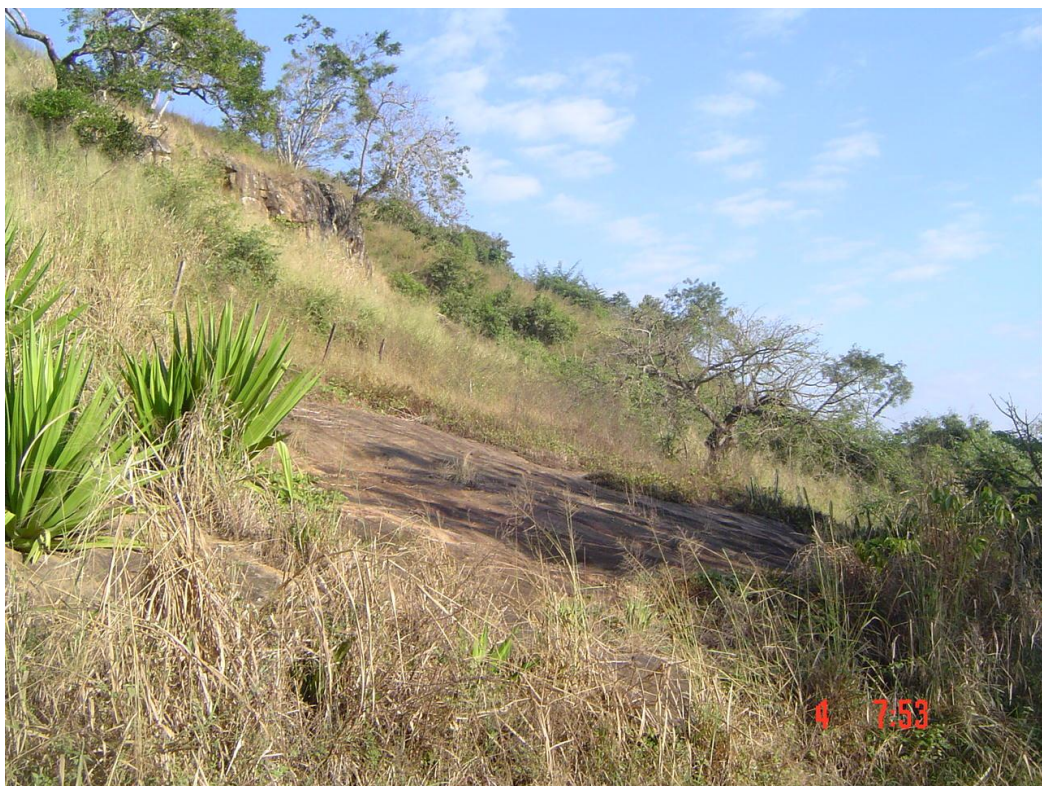
Foto 12 – Afloramento de rocha na ombreira direita.
