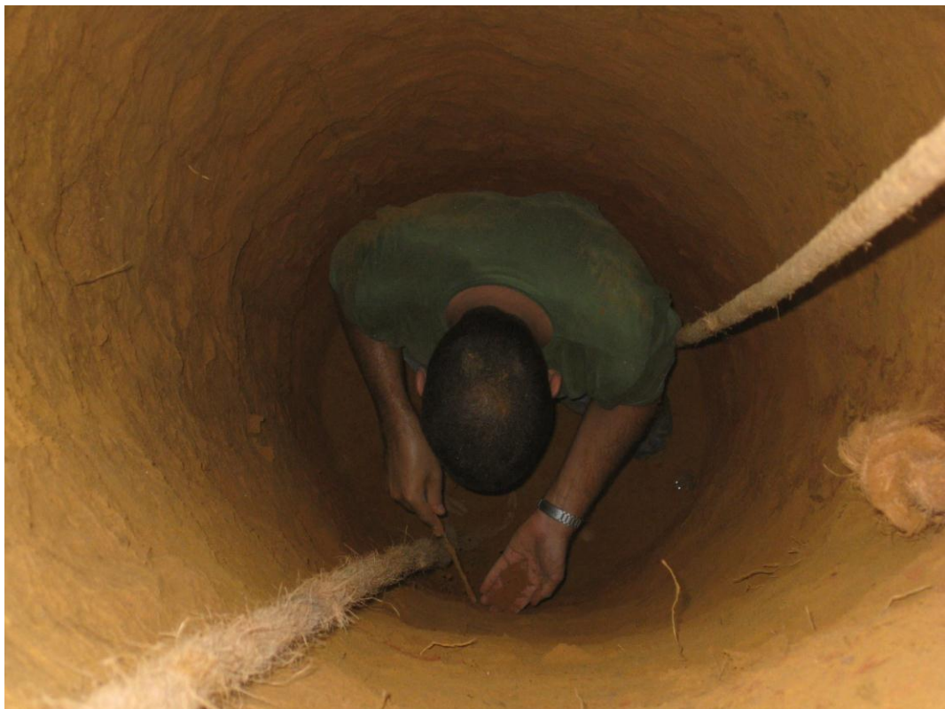
Foto 15 – Inspeção de poço (PEC-05) na margem esquerda.
