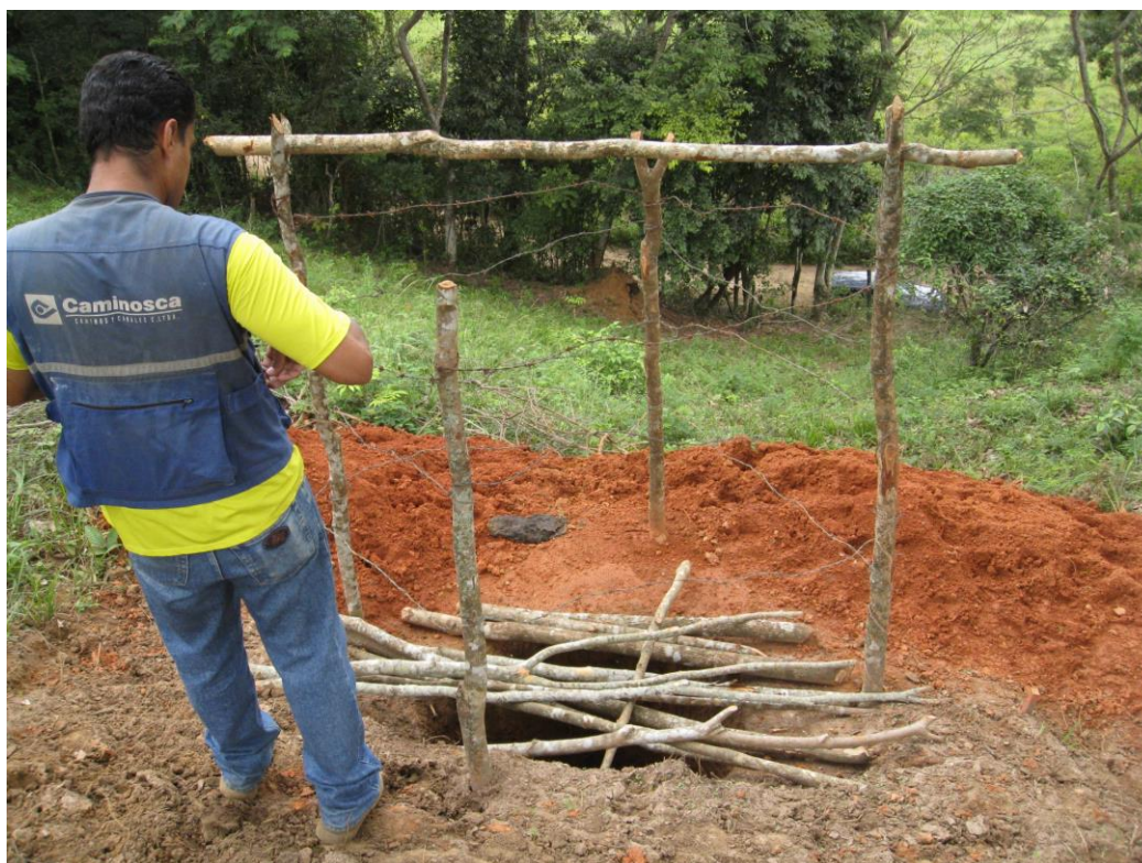
Foto 14 – Poço de Inspeção (PI-02) na margem esquerda.
