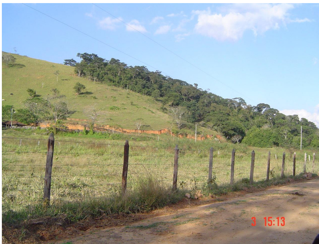
Foto 5 - Vista de montante pra jusante da ombreira esquerda do barramento.
