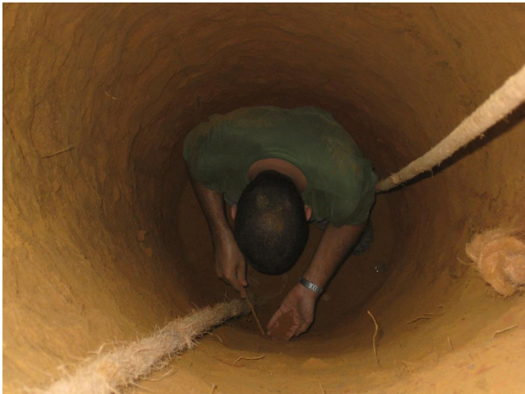
Foto 15 – Inspeção de poço (PEC-05) na margem esquerda.
