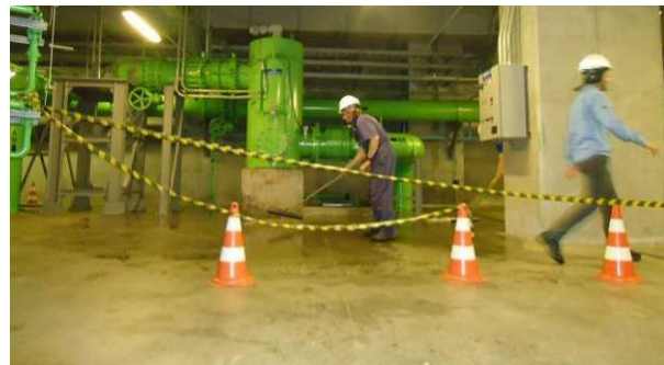
Rompimento do Filtro de água da Unidade Geradora 02. INUNDAÇÃO DA CASA DE FORÇA (PE-UF-SS-1) em 24/09/2013
