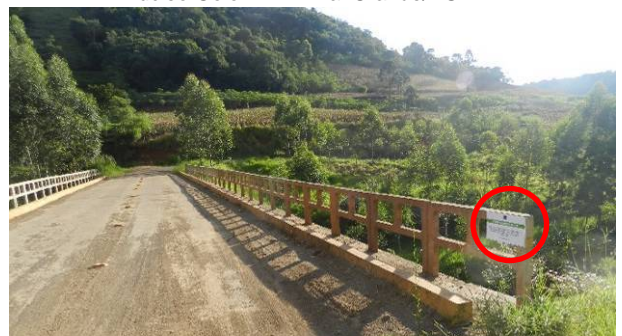
Ponte Lajeado Lava Pé – Ita/SC
