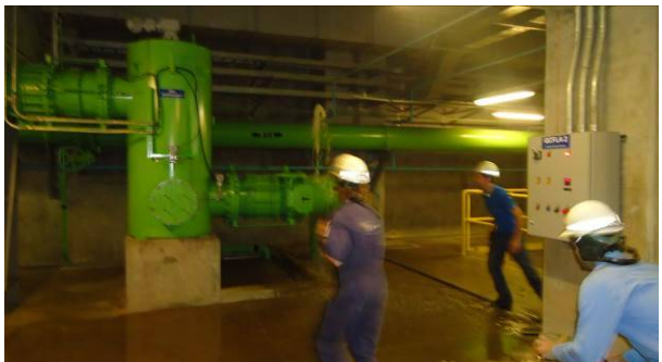
Rompimento do Filtro de água da Unidade Geradora 02. INUNDAÇÃO DA CASA DE FORÇA (PE-UF-SS-1) em 24/09/2013
