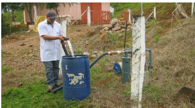
Medição de vazão no poço PAI06
