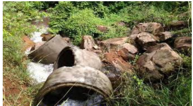
FOTO 7: DRENAGEM A SER RECUPERADA EM ESTRADA DO MUNICÍPIO DE ALPESTRE – E53
