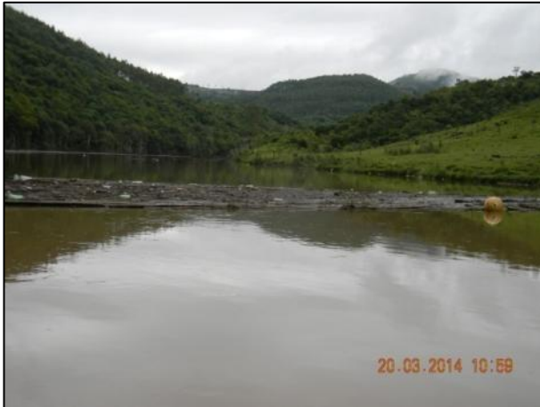
Figura 42. Vista geral do tributário rio Irani, onde pode ser observada grande quantidade de matéria orgânica ancorada à barreira de contenção.
