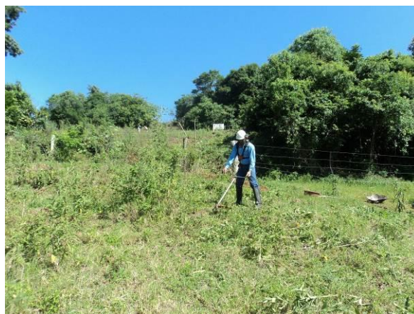
Limpeza da Seção topobatimétrica nº 06, em 09/01/2014.
