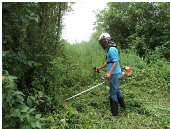
Limpeza da Seção topobatimétrica nº 04, em 09/01/2014.
