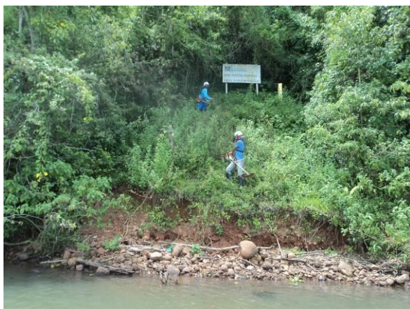
Limpeza da Seção topobatimétrica nº 07, em 08/01/2014.
