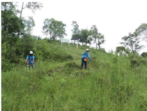
Limpeza da Seção topobatimétrica nº 05, em 09/01/2014.
