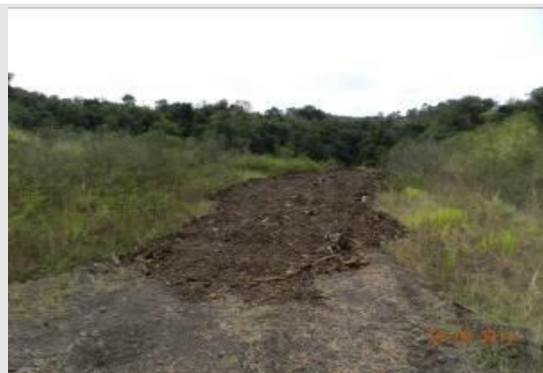
Área do enchedor de pipa, material colocado em área degradada para reafeiçoamento e posterior recuperação.
