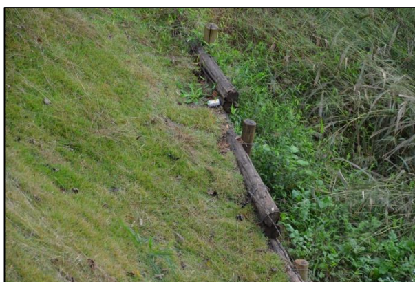
Figura 2.2-VI: Detalhes das estruturas de madeira
