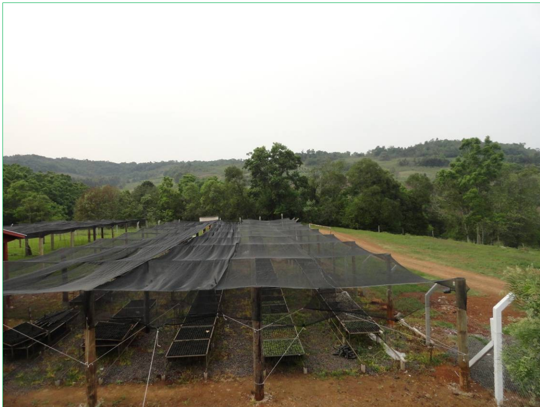
Vista geral da cobertura do viveiro.
