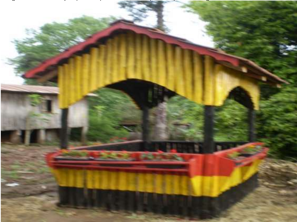
Imagem 29: Construção para depósito de lixo separado por reciclagem
