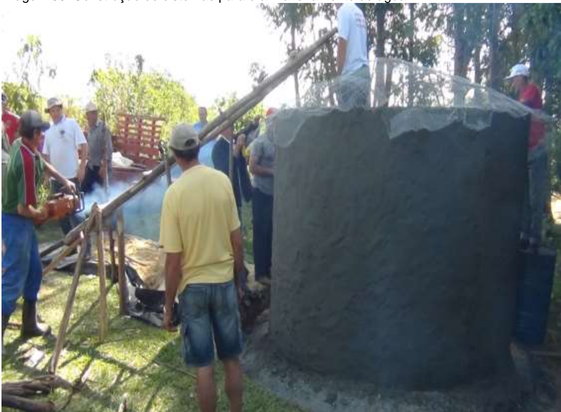
Imagem 30: Construção de cisternas para o armazenamento de água
