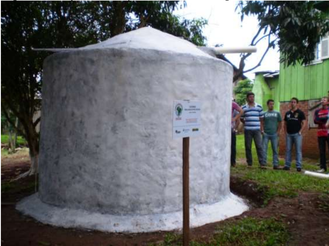
Imagem 31: Construção de cisternas para o armazenamento de água
