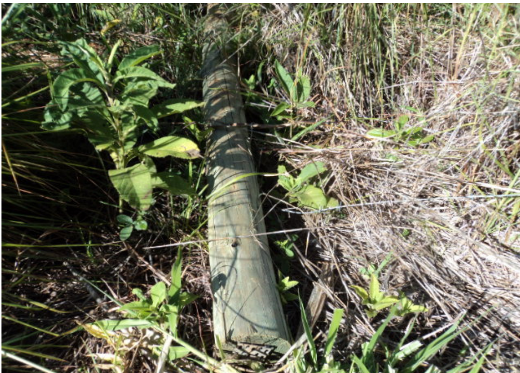
Foto 5: Palanque com cerca derrubado em área de APP.
