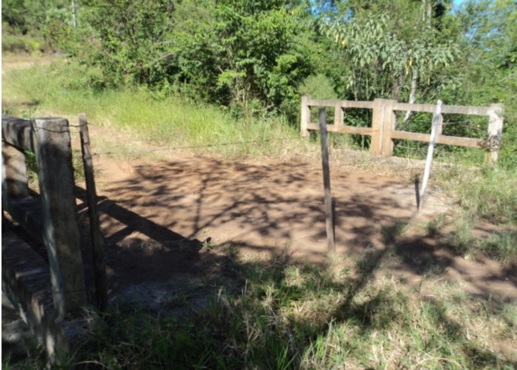
Foto 4: Ponte fechada no início da área REFC-E-0035.
