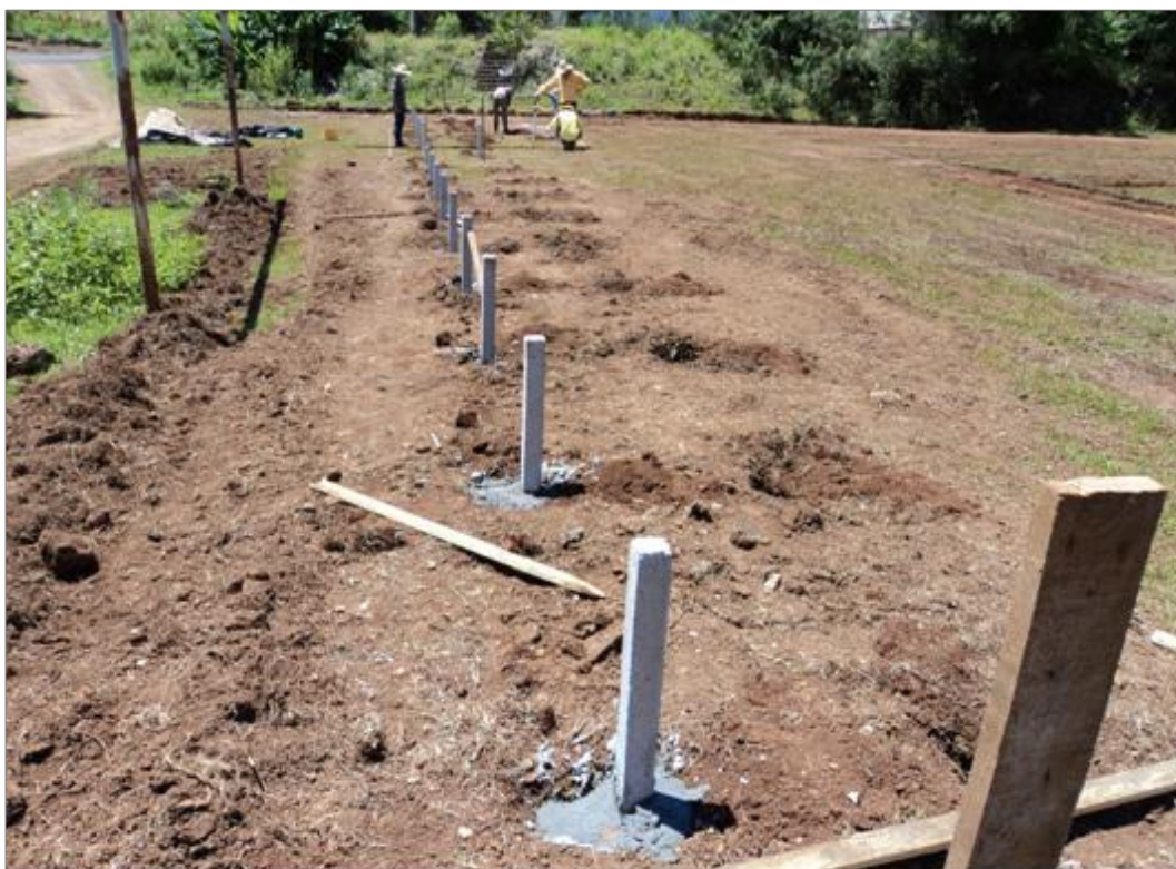
Alinhamento de palanques.
