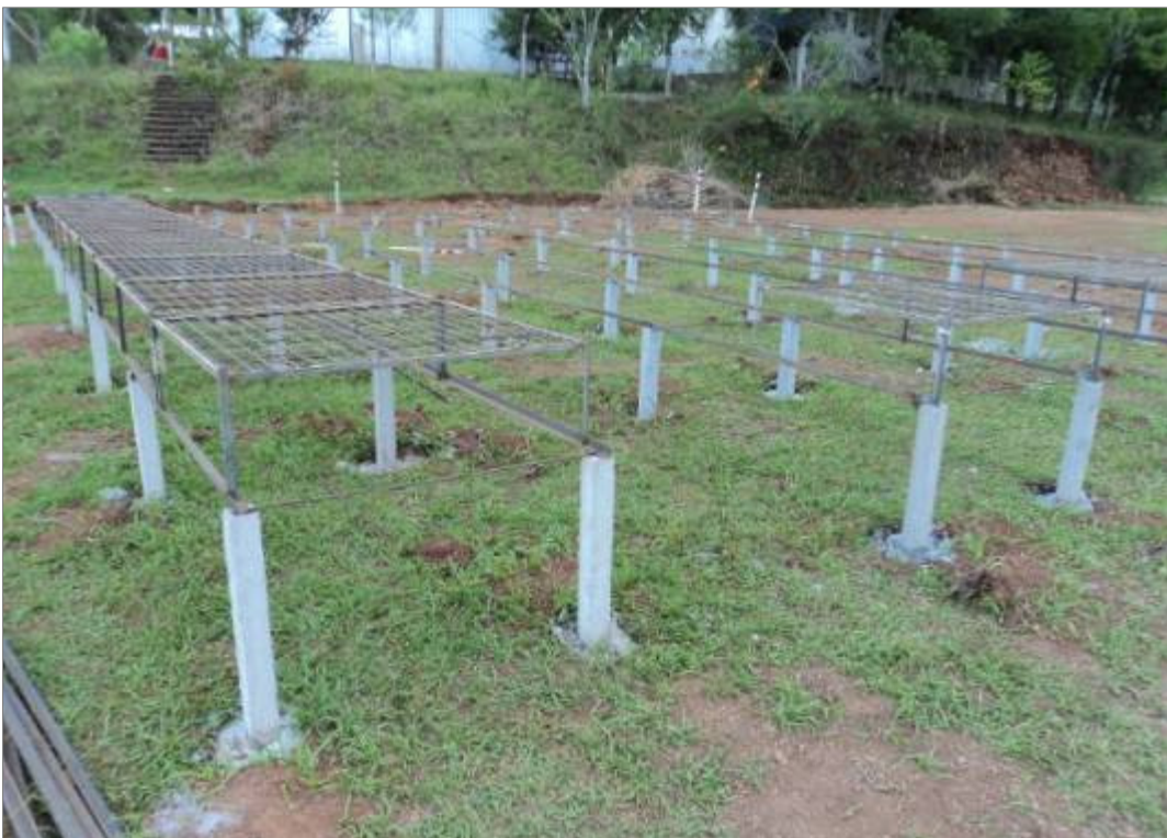
Instalação das canaletas de suporte das bandejas.
