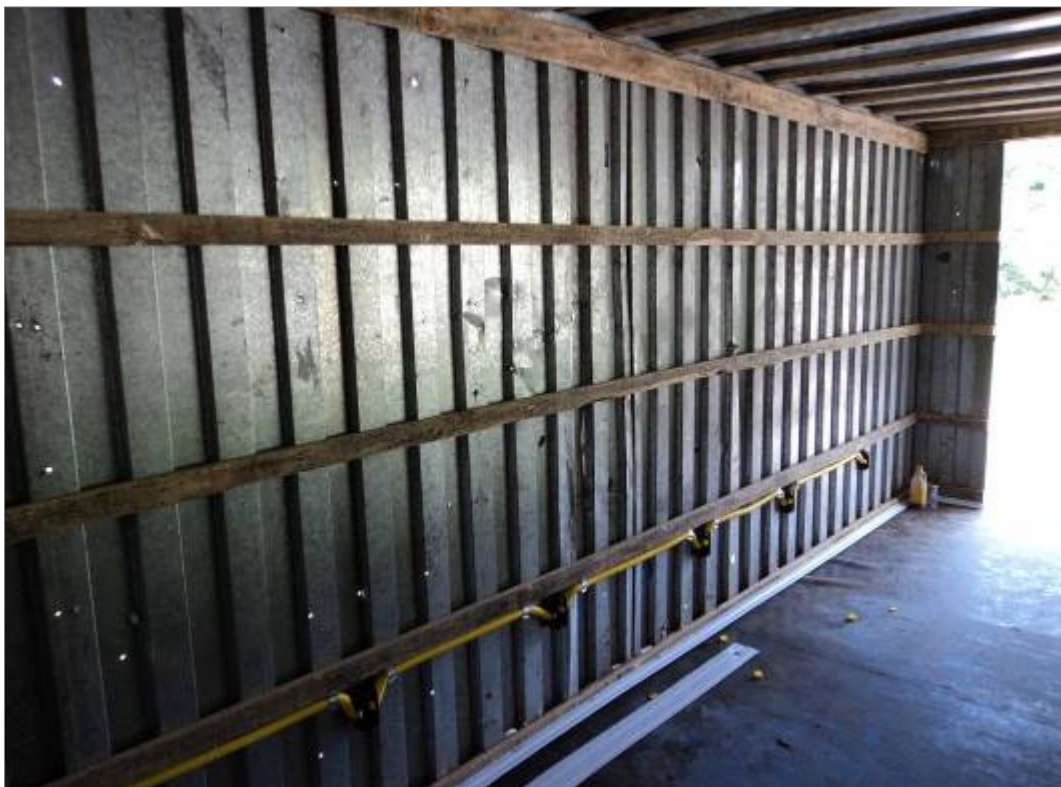
Início da instalação elétrica.
