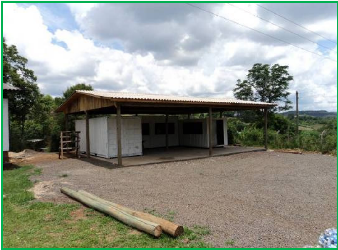
Contêineres já pintados com cobertura para proteção.
