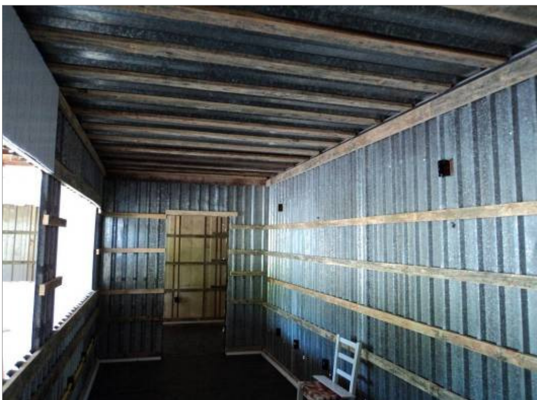
Preparação com ripas para a forração.
