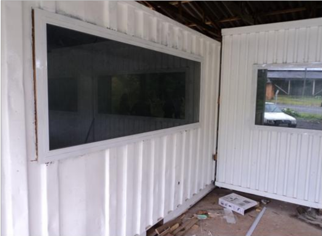
Vista externa dos vidros.
