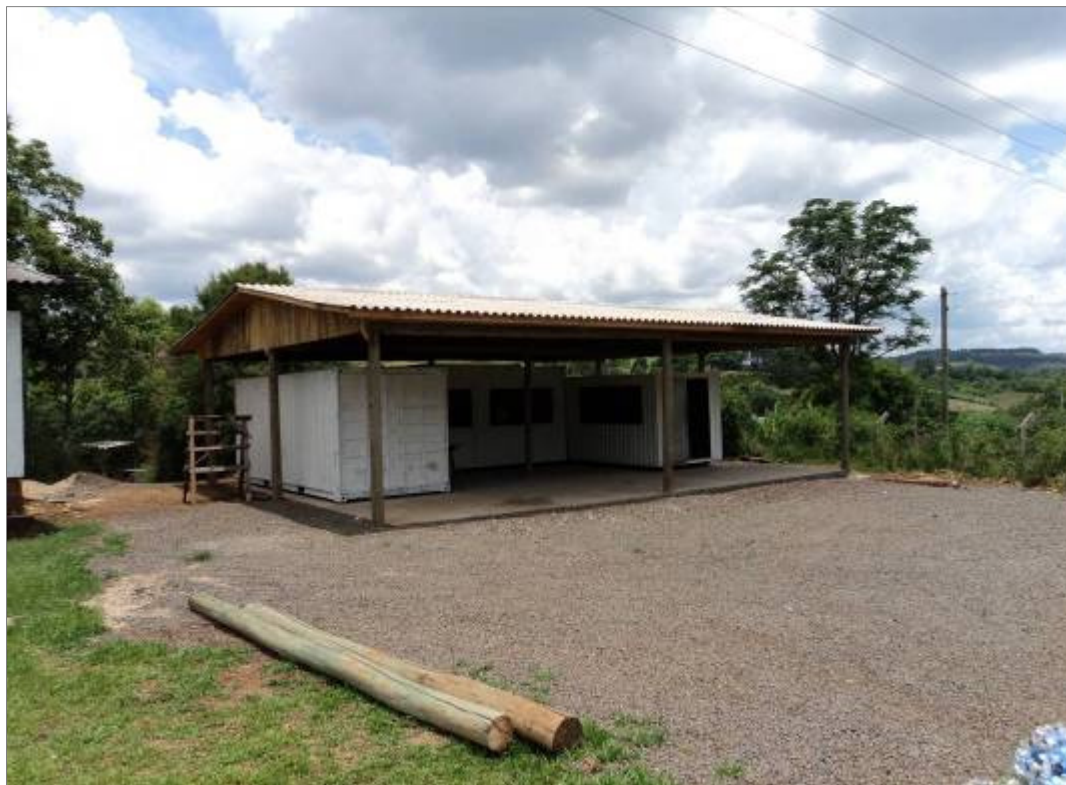
Contêineres já pintados com cobertura para proteção.
