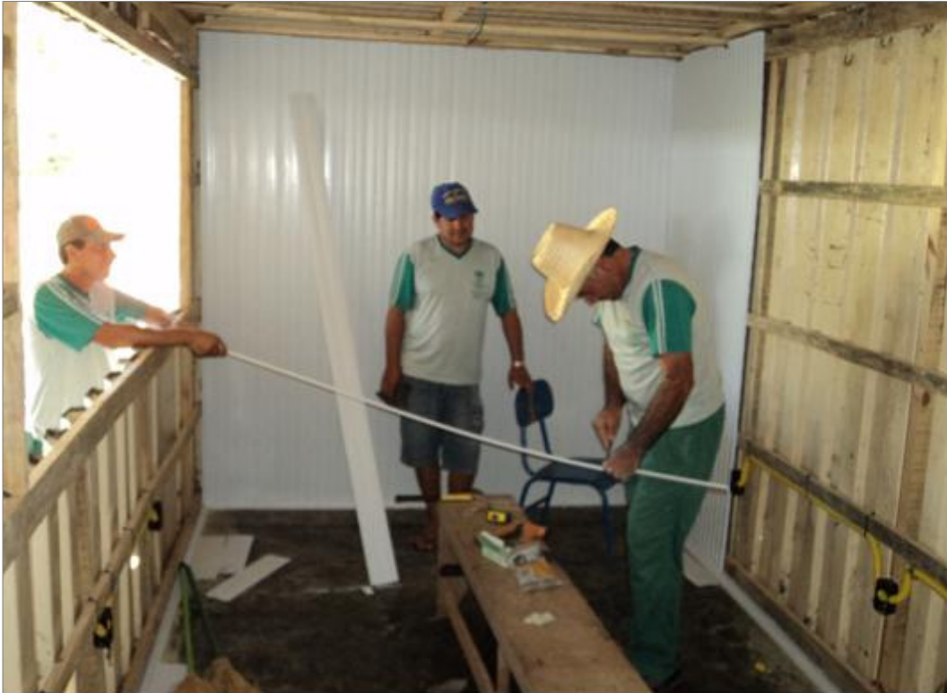
Início da forração interna.
