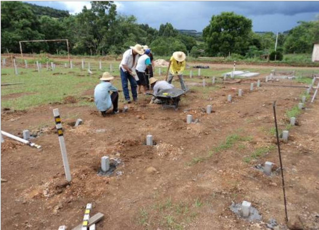
Nivelamento das linhas de palanques.
