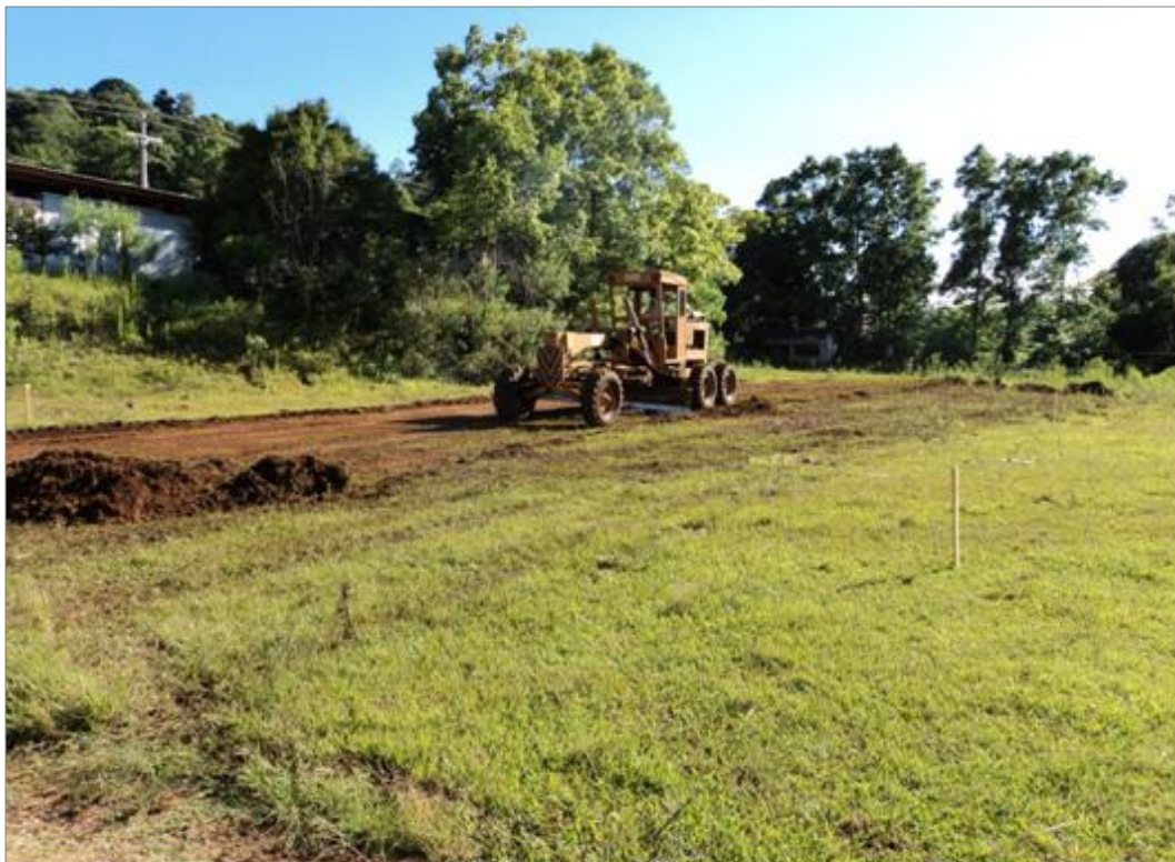
Nivelamento do terreno.
