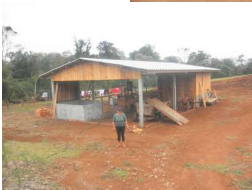
Benfeitoria de Apoio Galpao
