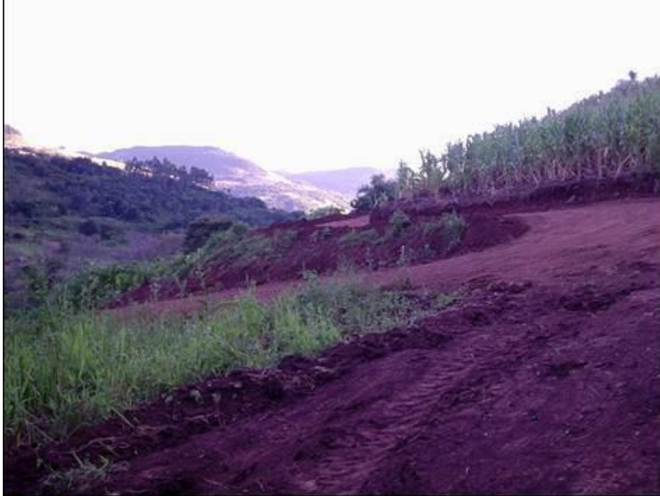
Figura 5.1.4.5 - Foto atual da antiga subárea IA inutilizada pela atividade agrícola e pela construção de uma estrada.
