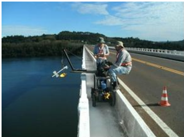
Medição de Vazão da (31/05/2012)
