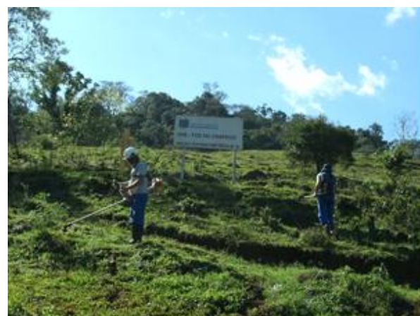
Limpeza na seção topobatimétrica nº 12, em 14/08/12.
