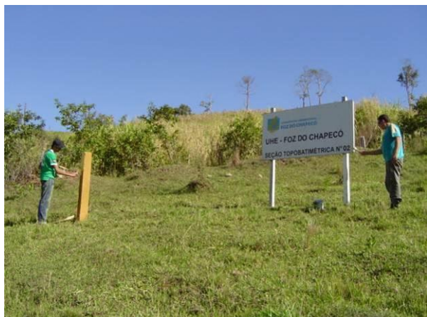
Manutenção, pintura e limpeza da Seção topobatimétrica nº 02, em 30/03/12.
