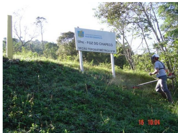
Limpeza da seção topobatimétrica nº 09, em 16/05/12.
