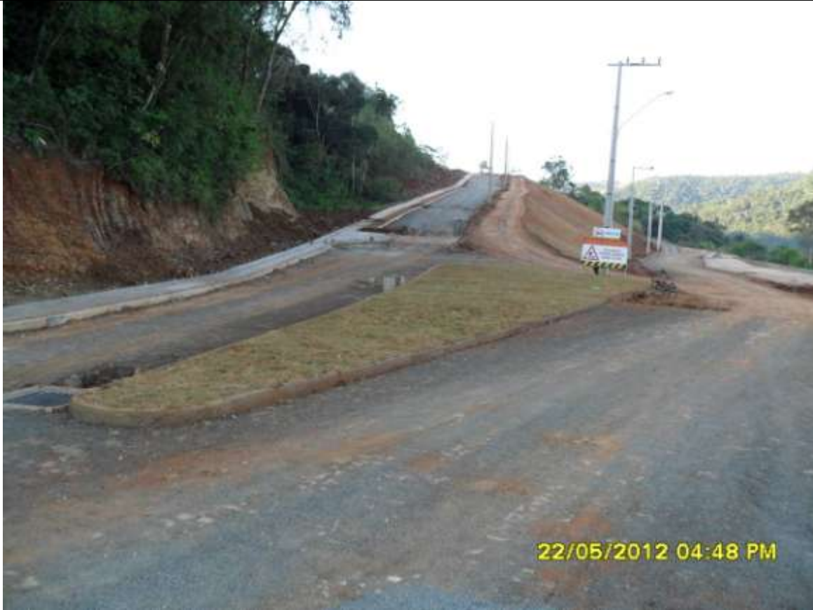
FOTOGRAFIA 11: FOTOGRAFIA OBTIDA NO LOCAL – PAVIMENTAÇÃO DAS VIAS DE ACESSO.
