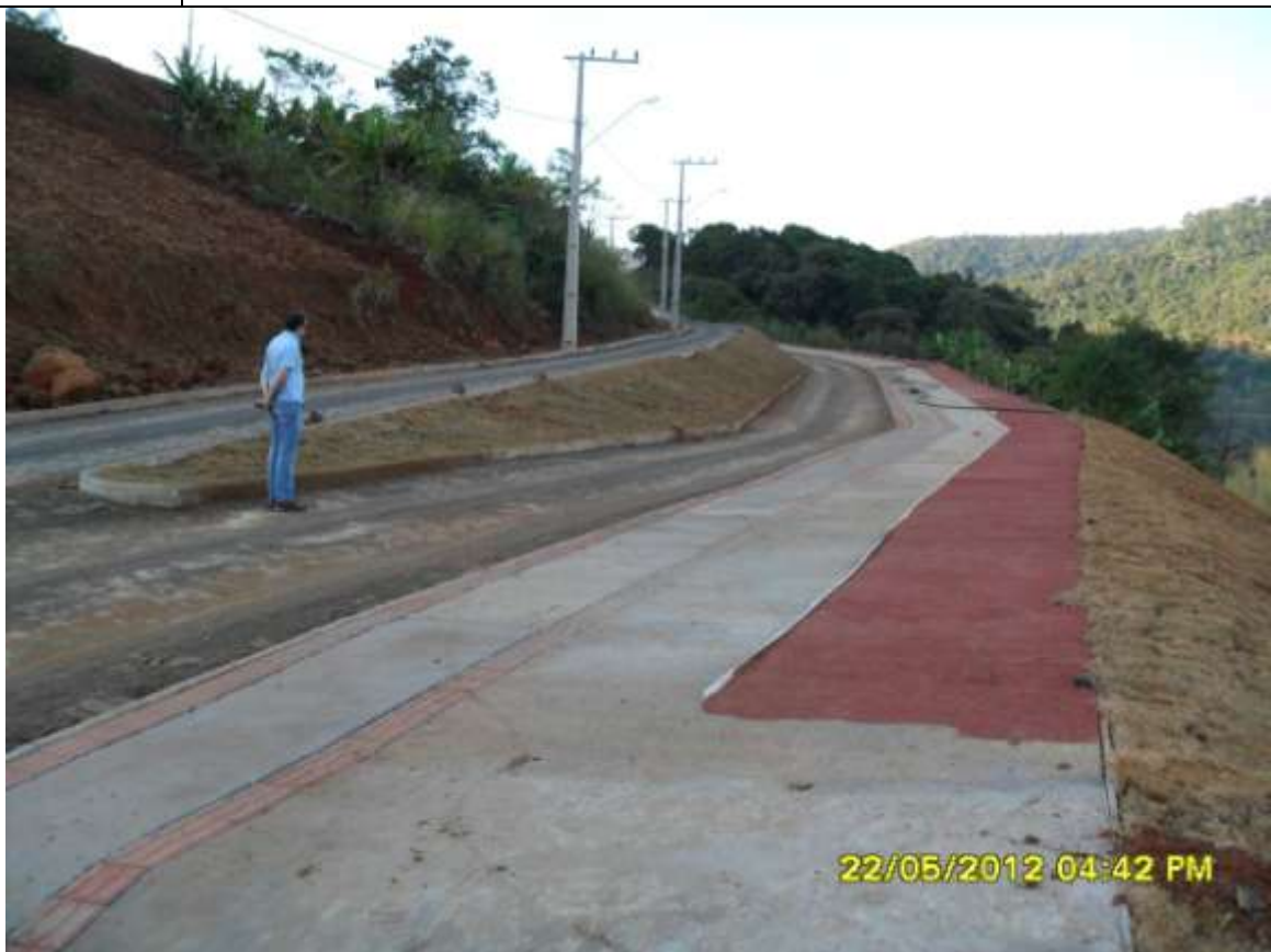
FOTOGRAFIA 12: FOTOGRAFIA OBTIDA NO LOCAL – PAVIMENTAÇÃO DAS VIAS DE ACESSO.
