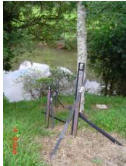
Seção de Régua Limnimétrica (14/03/2011)
