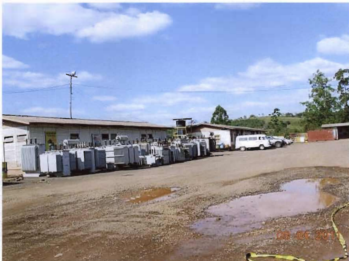
Atual Escritório Central = Desmobilização em andamento.
