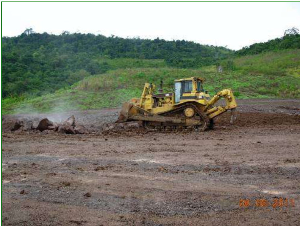
Foto 04. Reafeiçoamento da Oficina ME.
