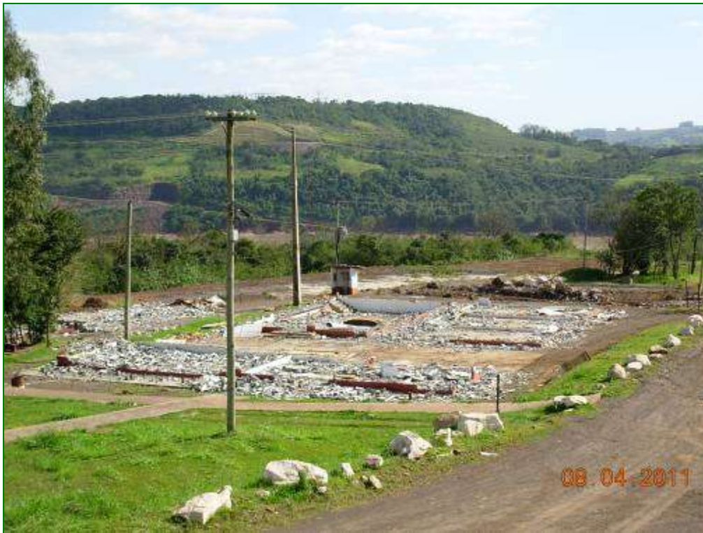
Foto 03. Desmobilização do Centro de Lazer.
