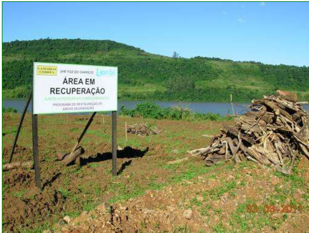
Foto 11. Galharias no Pátio de Pré-Moldados.
