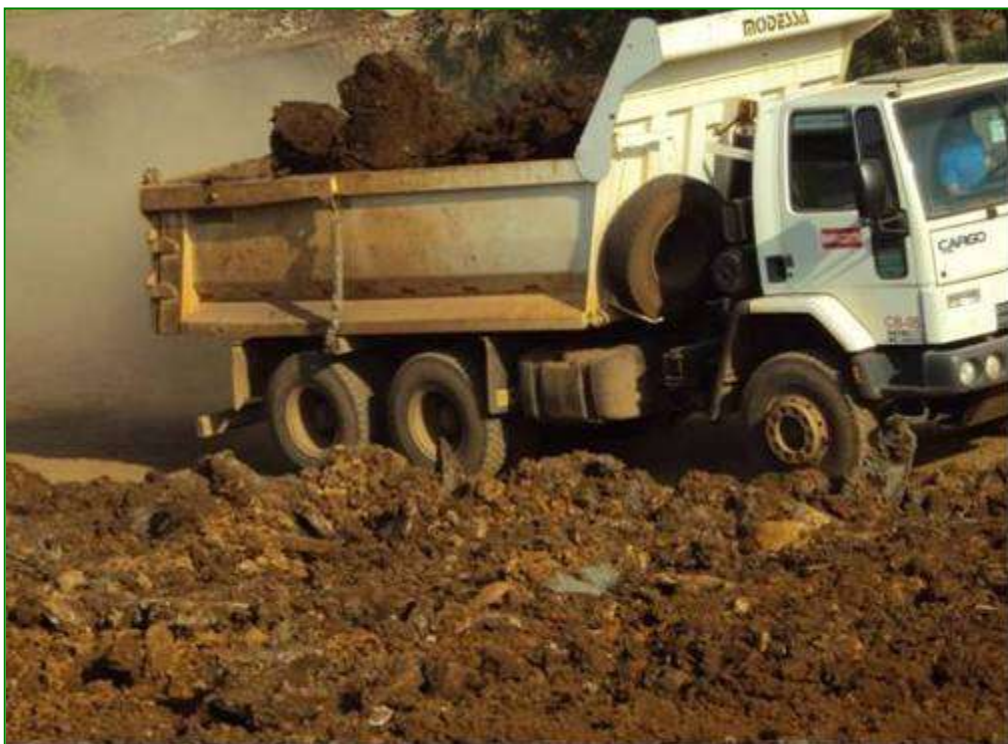
Foto 06. Reafeiçoamento do Centro de Lazer.
