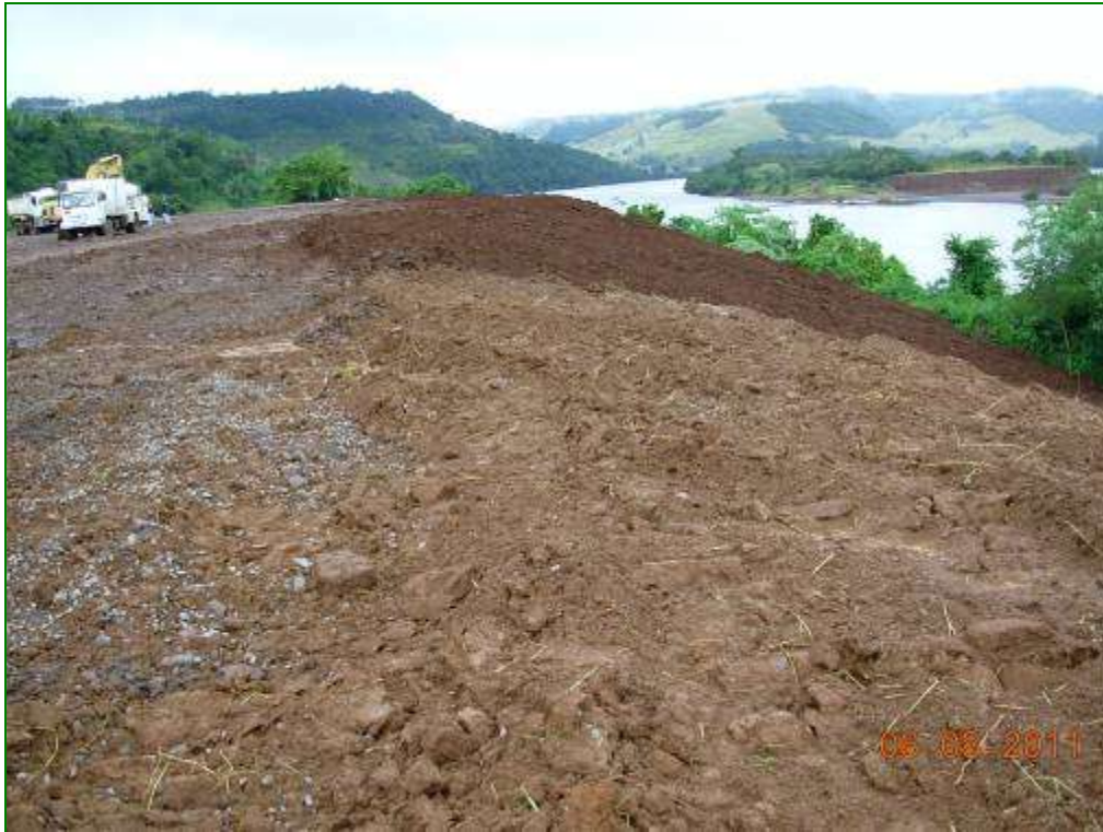
Foto 05. Reafeiçoamento da Oficina ME
