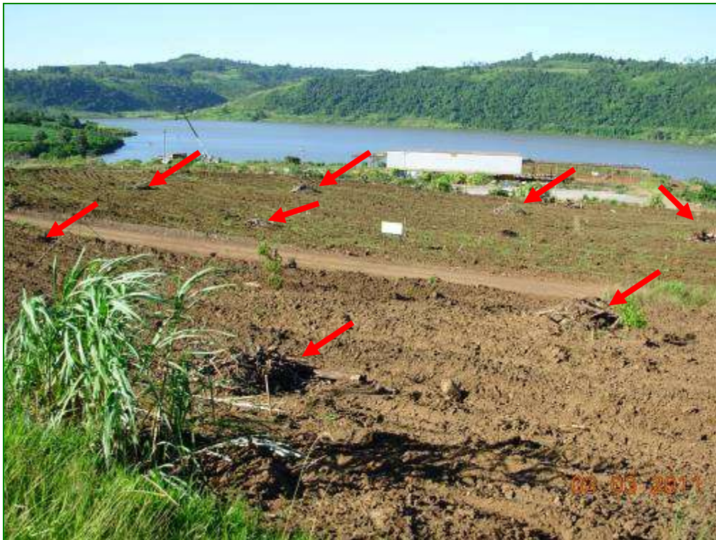
Foto 10. Galharias transpostas na Usina de Asfalto.
