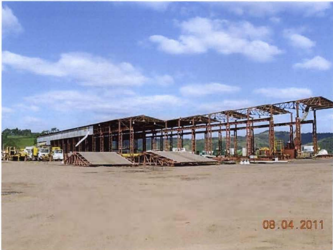
Oficina/Manutenção = Desmobilização em andamento.
