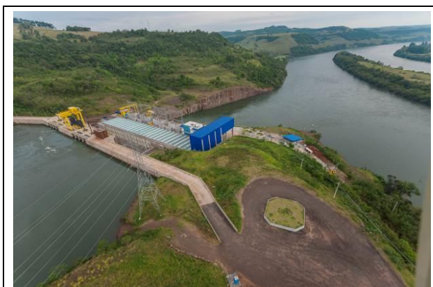
Figura 3.3-1 Vista da área da casa de força (ZCO). Fonte: FCE, 2018.
