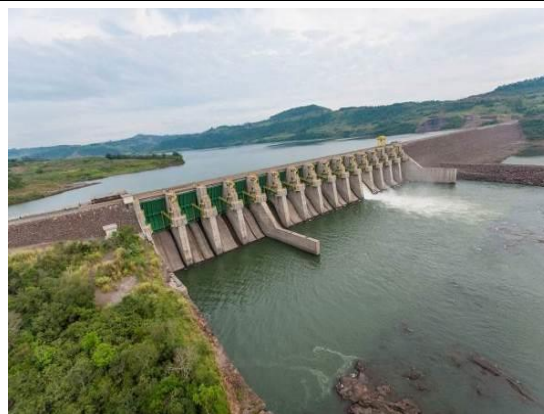
Figura 3.1-2 Vista da Zona de Segurança, a montante e jusante do barramento. Fonte: FCE, 2018.
