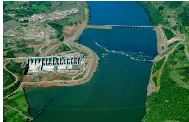
FOTO 33: VISTA AÉREA DO VERTEDOURO
