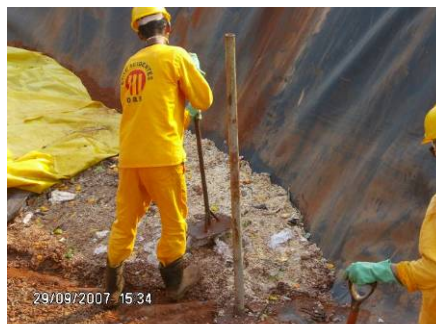
Foto 6. Compactação dos resíduos orgânicos na vala do aterro sanitário.
