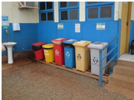
Foto 1. Sistema padrão de cores adotado para todos os recipientes coletores dispostos nos diferentes locais do canteiro de obras..
