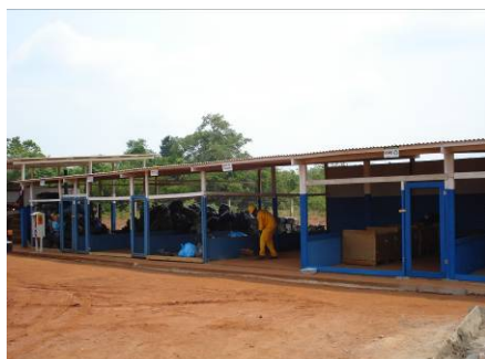
Foto 3. Área de segregação e baias de estocagem de resíduos recicláveis.
