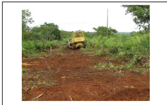
Foto 26 – Limpeza de área onde foi realizada supressão de vegetação.
