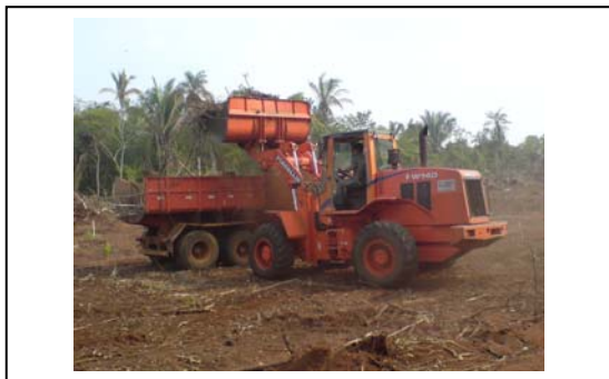
Foto 25 – Retirada de material lenhoso para área de estocagem de material vegetal.
