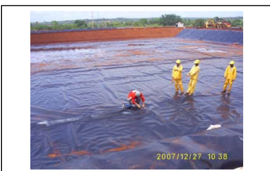
Foto 14. Instalação da geomembrana – Impermeabilização das lagoas.
