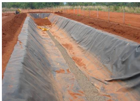
Foto 5. Primeira vala aberta no aterro sanitário. Observa-se a drenagem e a manta de impermeabilização.
