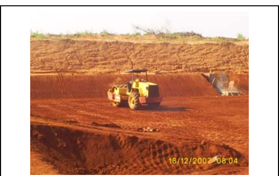
Foto 13. Compactação final da camada de argila
