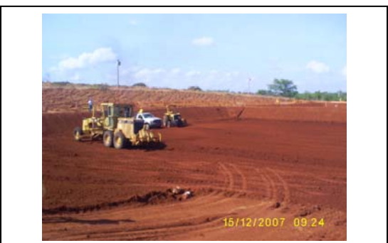
Foto 11. Nivelamento do fundo da lagoas. Camada de argila.
