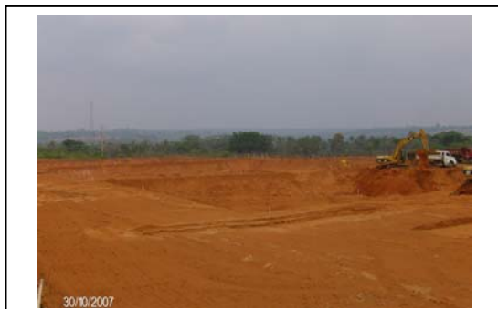
Foto 9. Escavação da lagoas
