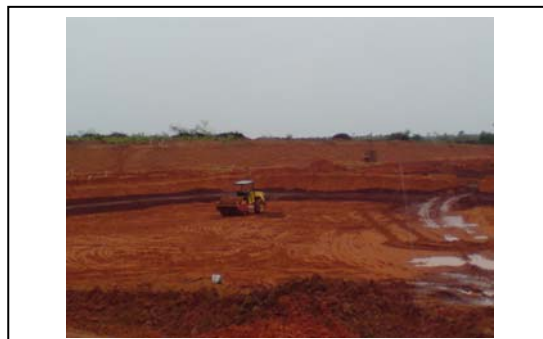
Foto 10. Terraplanagem e compactação do fundo das lagoas
