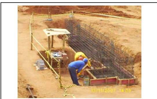
Foto 12. Construção do decantador e calha Parshall
