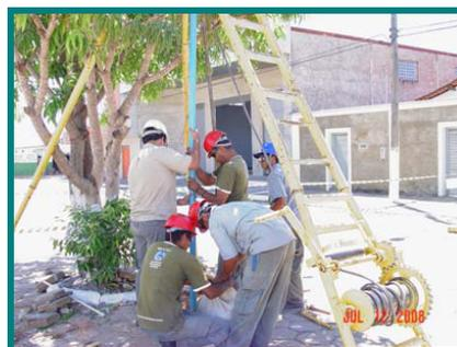
Foto 3.7-2- Instalação do revestimento
