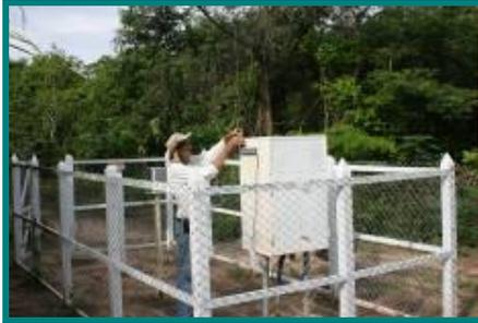
Foto 3.35-1 – Operação de aterramento da antena na estação telemétrica da EHS Itacajá-TO
