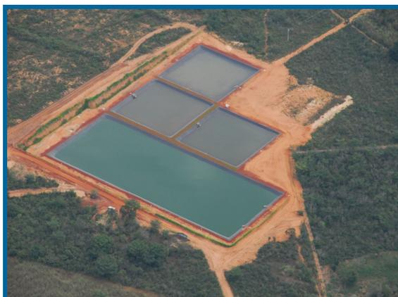
Foto. 3.2-2. Sistema de Lagoas de estabilização conformado por uma lagoa facultativa e três de maturação.
