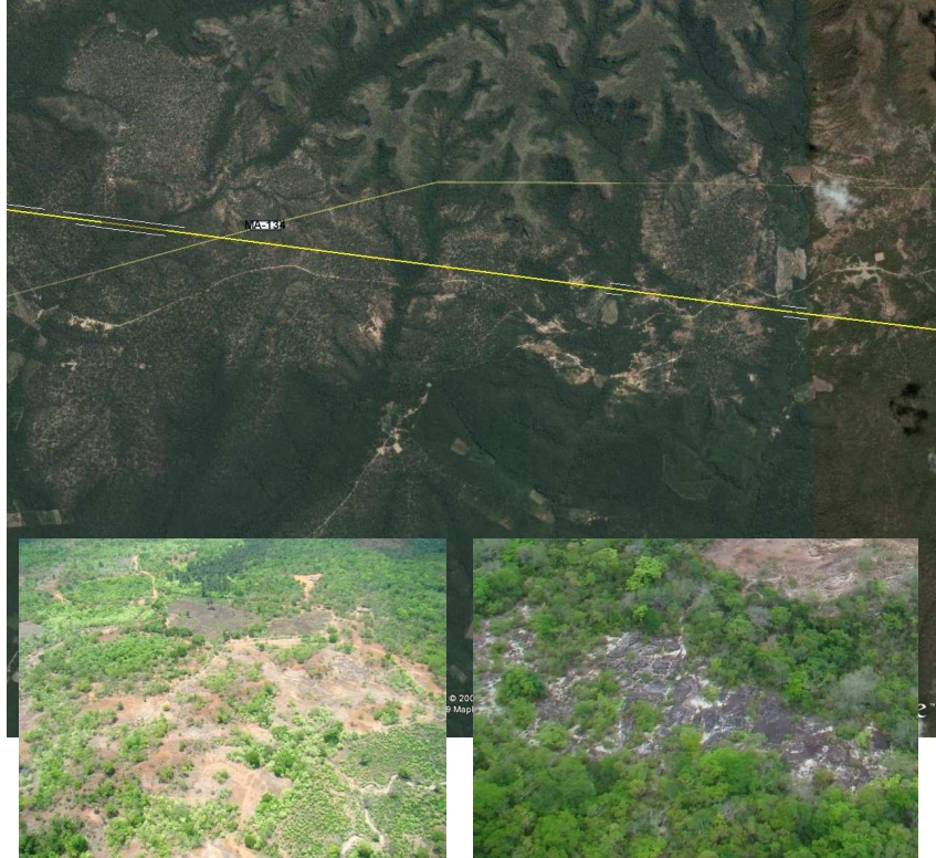
Figura 2.1-4 Porção média do trajeto da LT Estrito com topografia acidentada e vários pontos de solo exposto e afloramentos rochosos constatado em inspeção de campo e registrado nas fotos em detalhe (Foto: Emerson, 2009).
