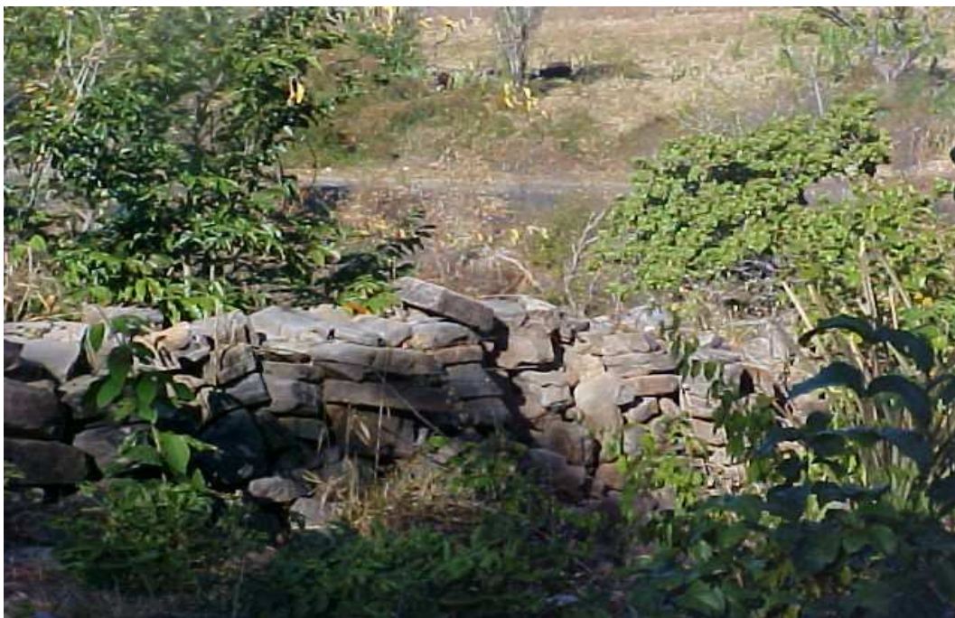
Foto 10-13 Muros de Pedra.
