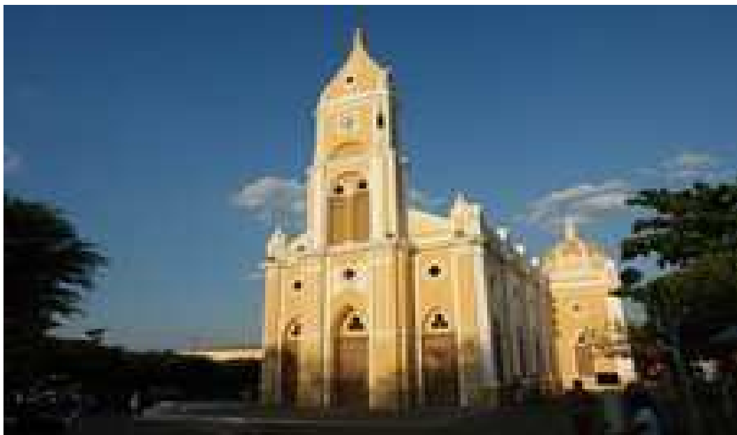
Foto 10-7 Igreja Matriz da Cidade de Floriano (PI), constitui-se num dos mais importantes marcos urbanos da paisagem construída da cidade.
