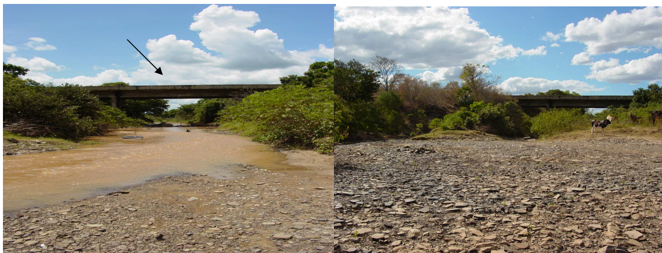
Foto 9.3.1-2 Vista da ponte sobre o rio Itaueiras, na BR-230 (seta), próximo a Floriano (PI), no local da estação ES-01, em abril (esquerda) e julho/2005 (direita).
