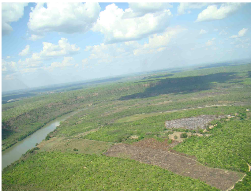
Foto 8.2-5 Eixo do AHE Estreito, com paredão na margem direita do rio Parnaíba.
