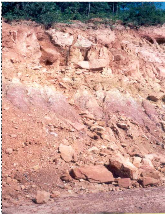
Figura 5.4-1 Mecanismo 1 - Queda de blocos por erosão diferencial no talude.
