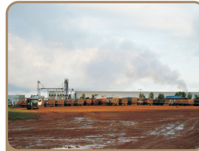
Figura 4-52: Acesso ao Terminal Ferroviário da ALL em Alto Araguaia a partir da BR-364
