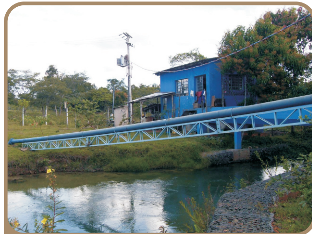
Figura 4-58: Córrego Gordura - Captação de Água para Abastecimento em Alto Araguaia
