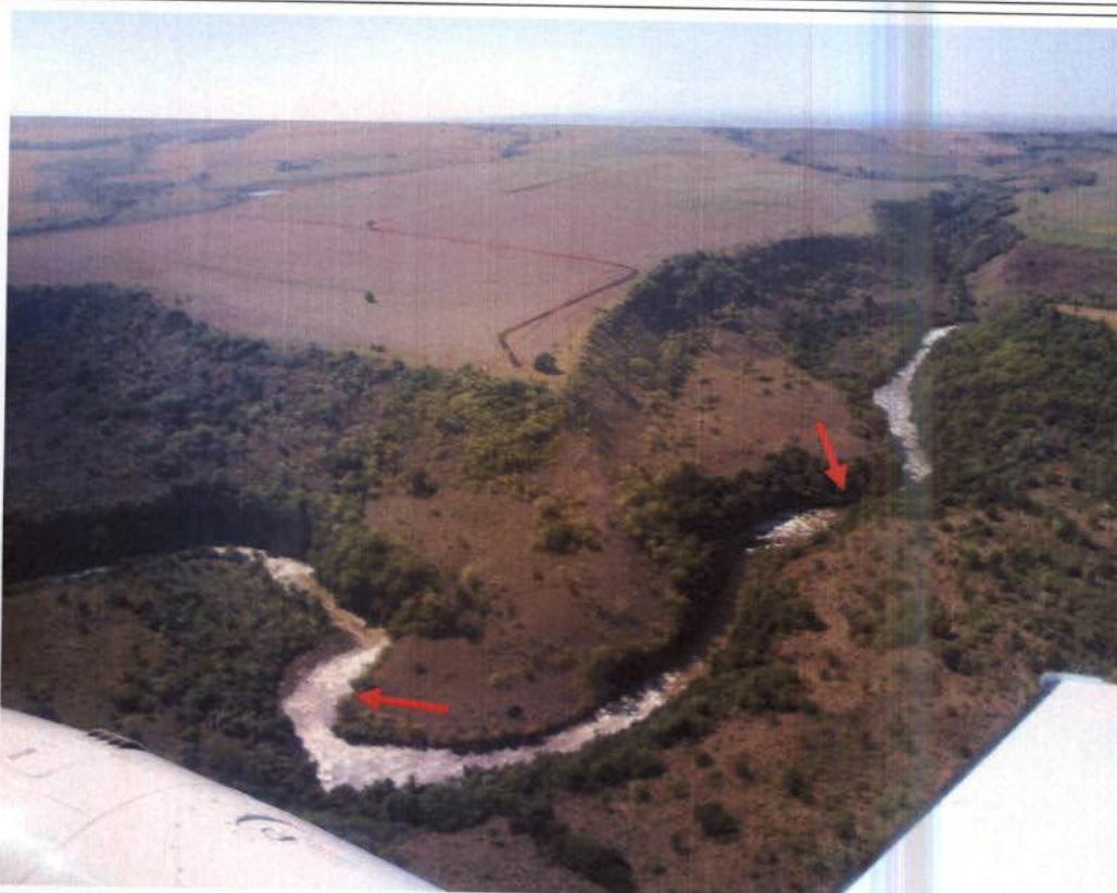
Foto 20. Vista aérea da porção média do trecho de vazão reduzida (TVR) a jusante da cachoeira de Couto Magalhães, encaixado em um vale. As setas indicam pontos vistoriados, posteriormente ao sobrevôo, por terra. Vale salientar a presença de muitas corredeiras e pequenas quedas d'água no TVR.
