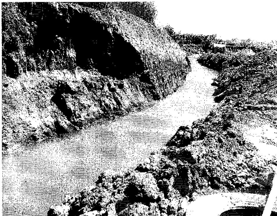
Figura 05 – Vista do Ribeirão das Antas a jusante do rompimento.
