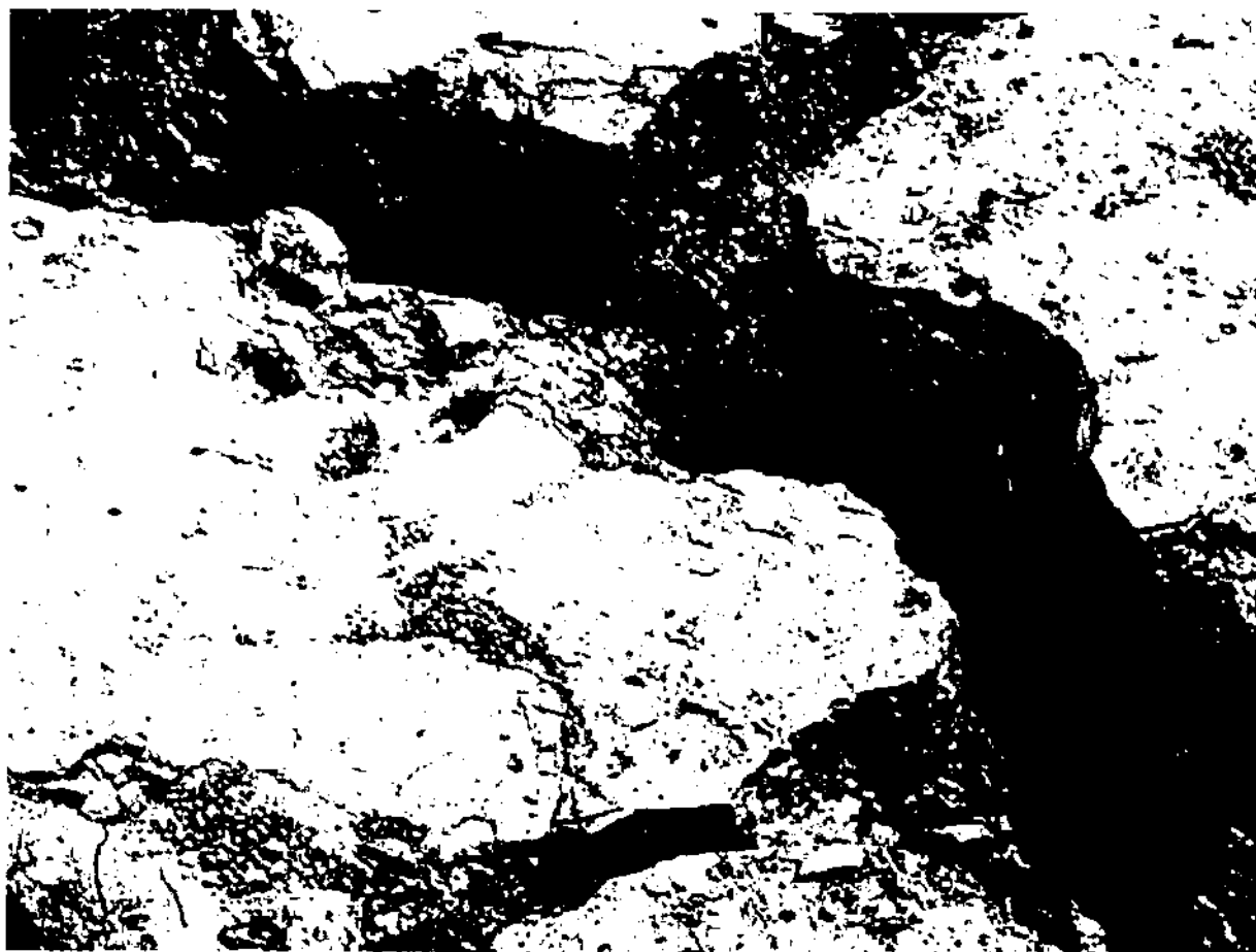
Agosto/2.004: No represamento de 2.004 (02 a 04/2.004) ficou depósitos de erosão, um barro, que com o secar rachou deixando fendas de 80cm até
