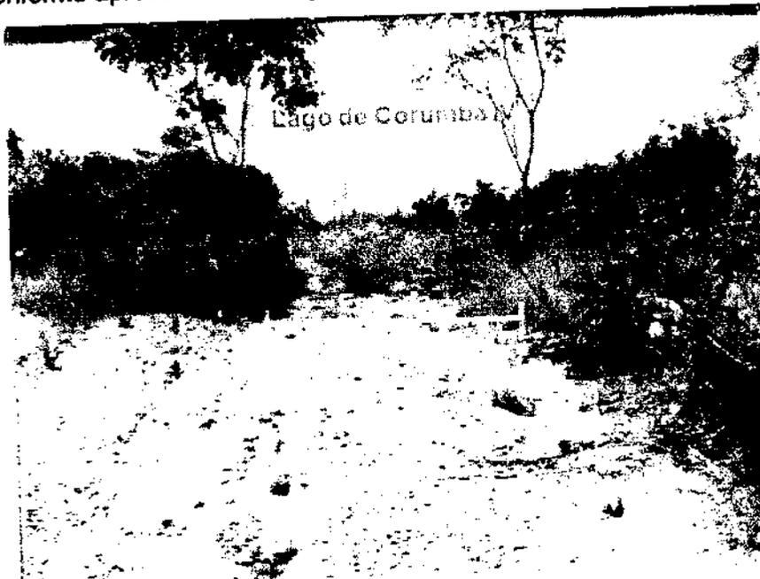
Figura 2 – Vista do início da estrada de acesso ao lago com erosões de sulco.
