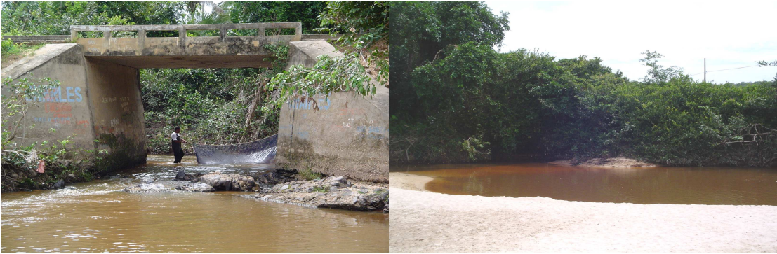
Foto 9.3.1-16 Vista do riacho dos Negros, no local da estação CT-11, sob a ponte na rodovia PI 130.
