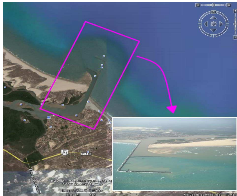
Figura 8.6-3 Vista aérea do Porto Luís Corrêa.
