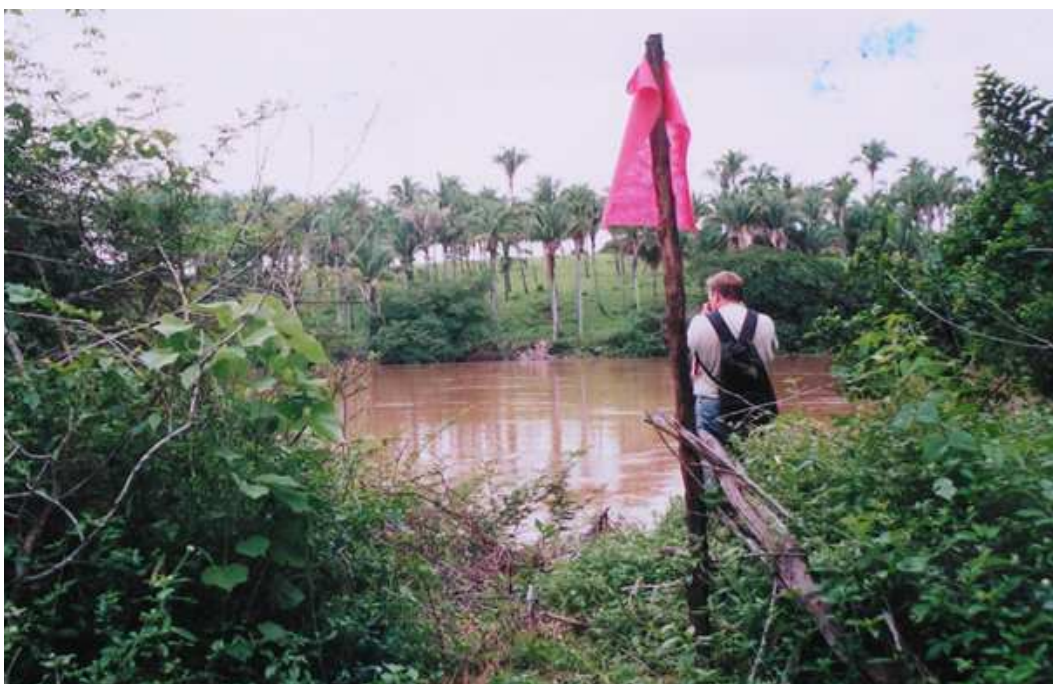
Foto 8.1-2 Panorâmica da ombreira esquerda no eixo da futura barragem.
