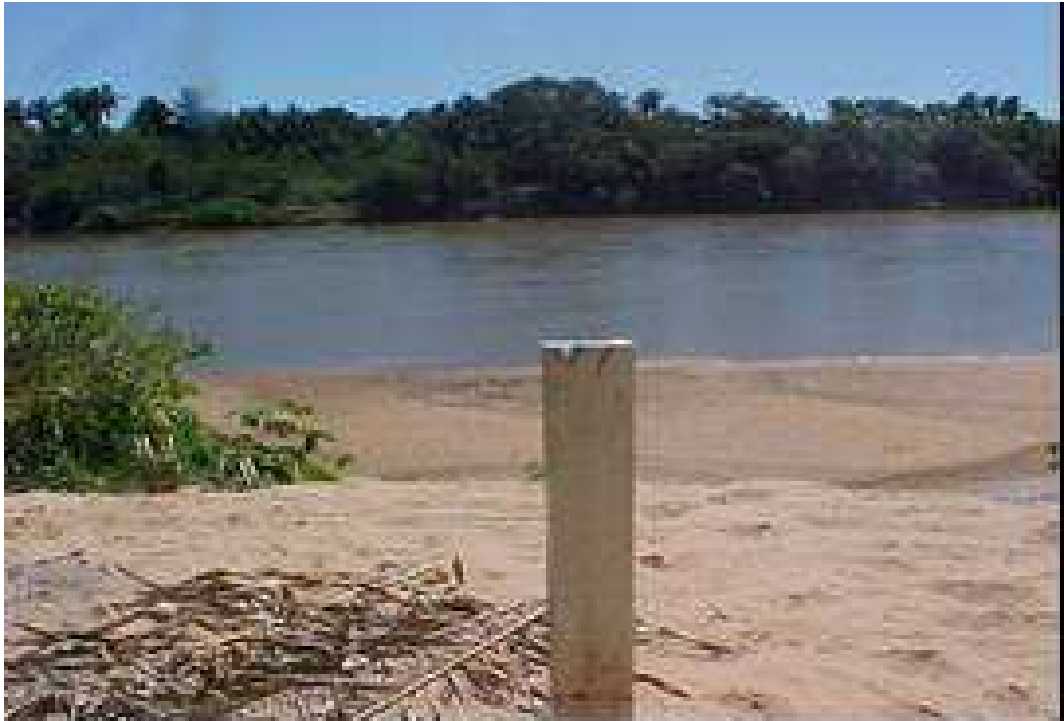
Fotos 10-12 Local no eixo da barragem previsto para a implantação do AHE Castelhana na localidade de localidade de Fidalgo (PI).
