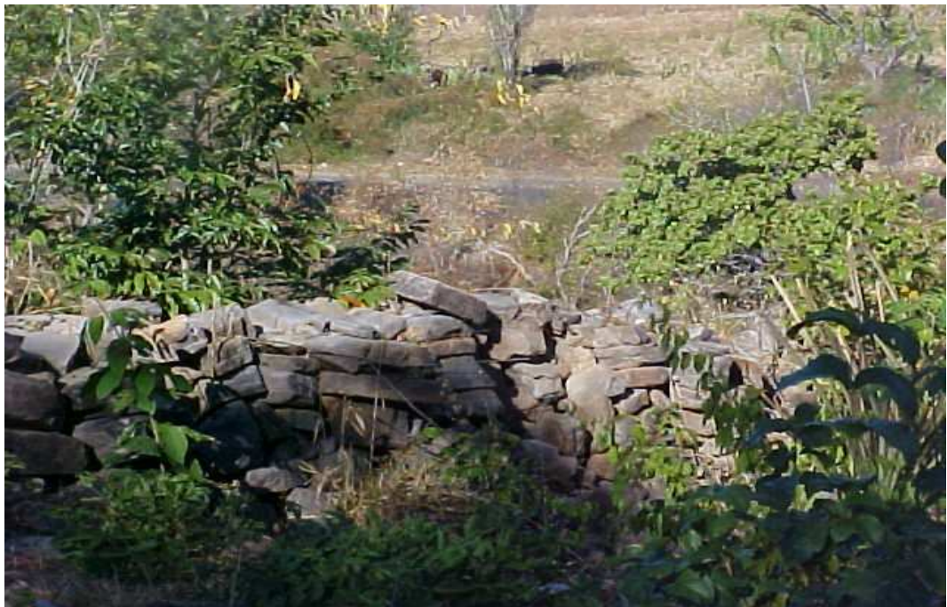
Foto 10-13 Muro de pedra em Amarante/PI.
