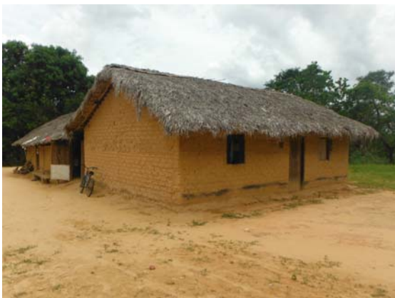
Figura 556: Habitação familiar às margens do Riacho Fundo, em cujo pátio foram detectados artefatos líticos. Foto: Jonathan Caino, 2014.
