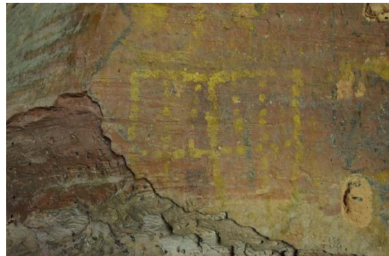
Figura 68: Detalhe do limite inferior do painel com pinturas, evidenciando o ponto onde ocorreu o deslocamento. Foto: Jonathan Caino,2014.
