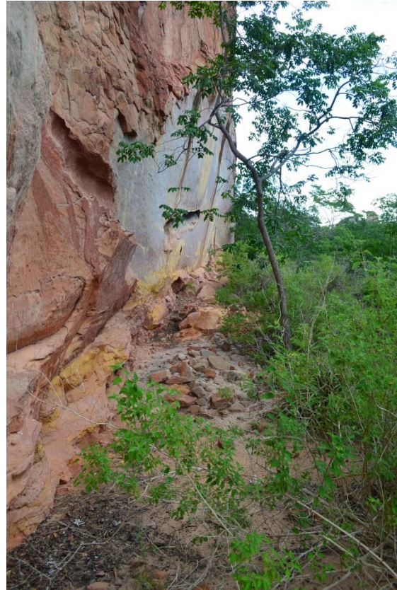
Figura 153: Vista geral do paredão. Nota-se a presença de muitos blocos desagregados no chão do abrigo, possivelmente, decorrente da porção mais erodida da rocha (cinza). Foto: Jonathan Caino, 2014.
