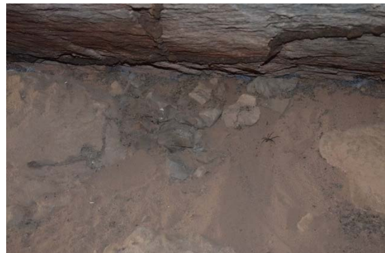
Figura 319: Blocos desprendidos da parede da caverna. Foto:Jonathan Caino,2014.
