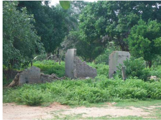
Figura 16: Ruína de edificação na sede da fazenda. Foto: Jonathan Caino,2014.
