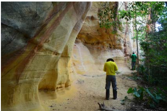
Figura 245: Paredão rochoso de arenito bastante erodido, destaque para os grafismos recentes. Foto: Jonathan Caino,2014.
