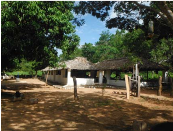
Figura 15: Sede da Fazenda Pedra Furada, em cujo pátio está a AOA. Foto: Jonathan Caino,2014.
