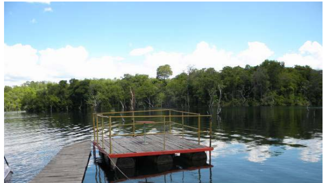
f) Vistoria complementar construção em APP
