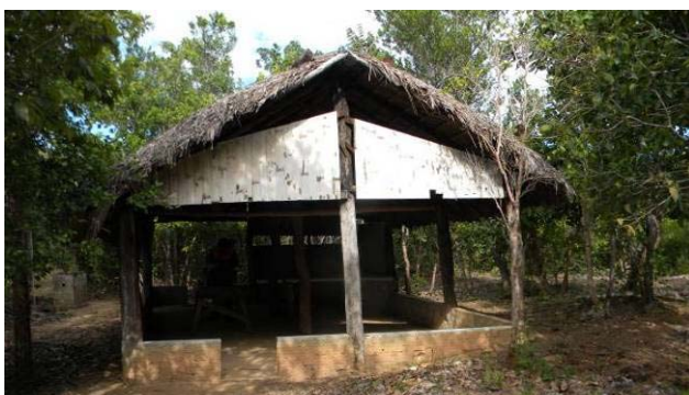
g) Vistoria de irregularidade na APP
