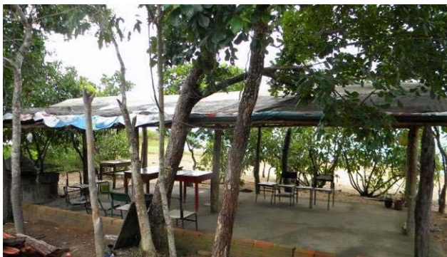
e) Vistoria complementar construção em APP
