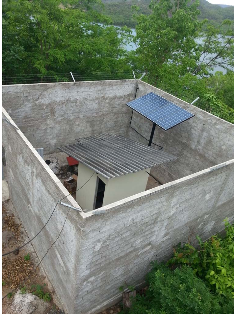
Figura 6 – Vista do muro de proteção da estação.
