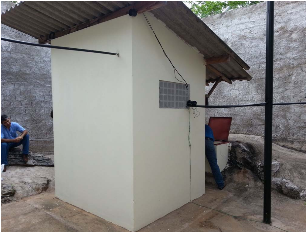
Figura 4 – Vista do abrigo principal e do abrigo do sismômetro, ao fundo.
