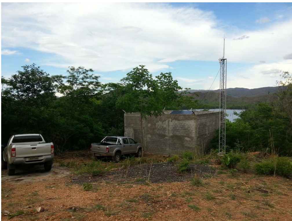
Figura 5 – Vista do muro de proteção e da torre de telecomunicação.
