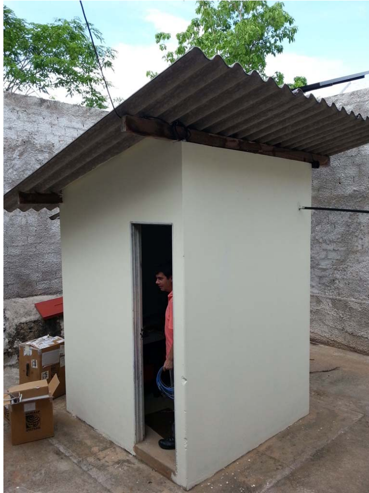
Figura 3 – Vista do abrigo principal.
