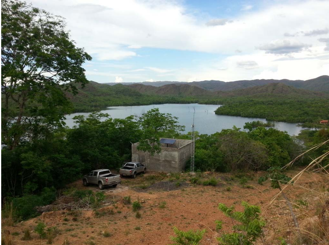
Figura 2 – Vista da Estação CAN1. Ao fundo, observa-se braço do reservatório da UHE Cana Brava.
