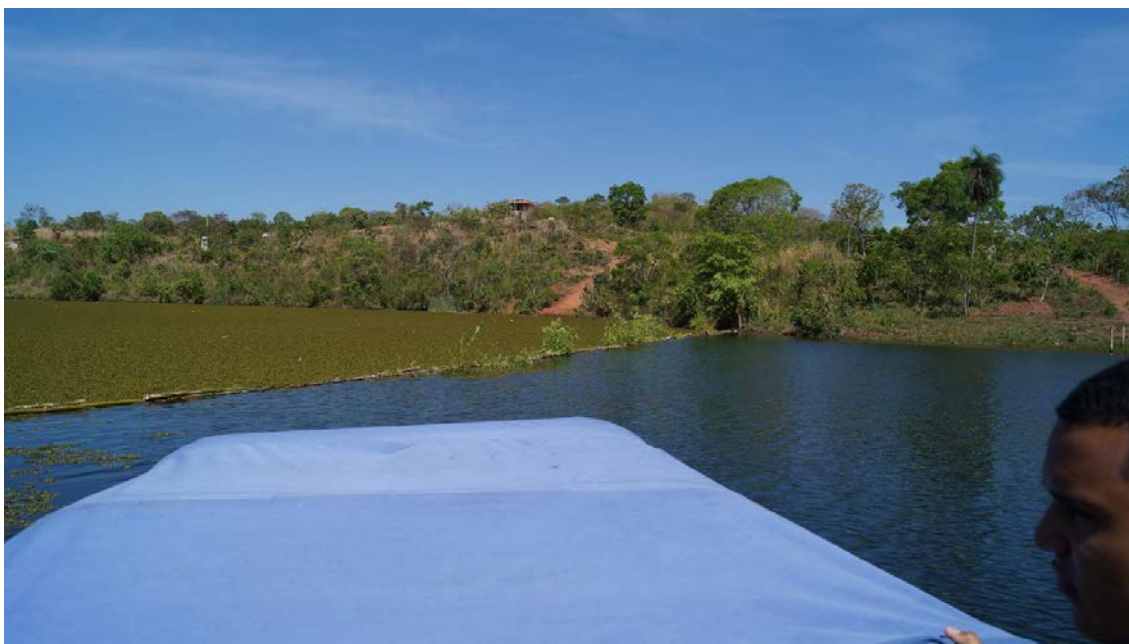
Figura 04: Vista geral da segunda contenção do rio Bonito, na direção da margem esquerda.
