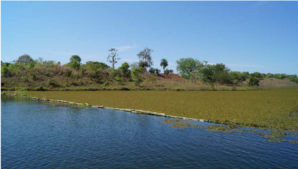
Figura 05: Vista geral da segunda contenção do rio Bonito, na direção da margem direita.
