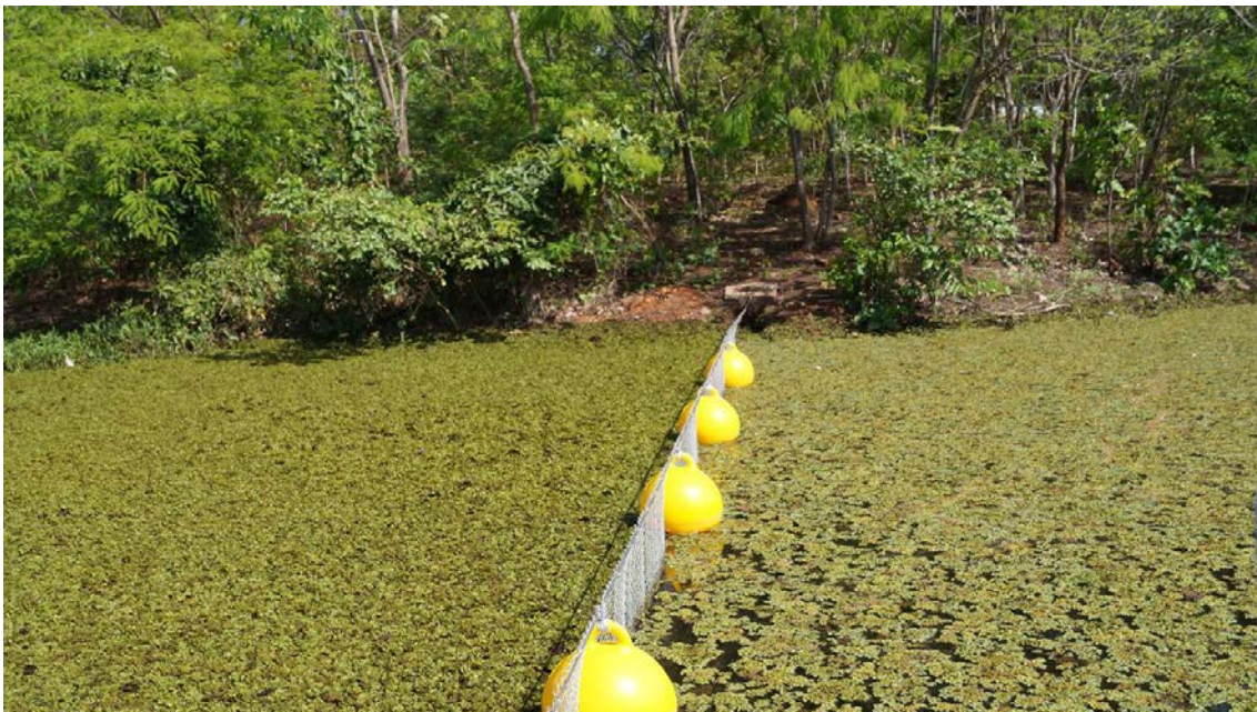
Figura 08: Detalhe do ancoramento da primeira contenção na margem esquerda do rio Bonito.
