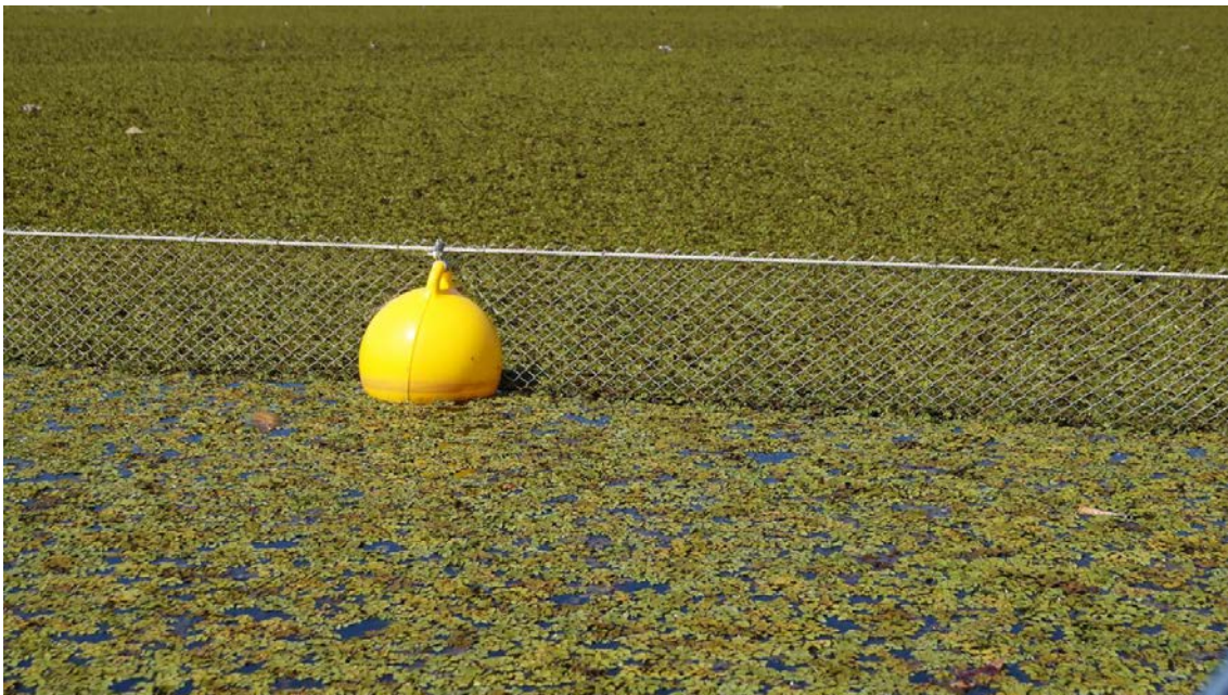
Figura 10: Detalhe da primeira contenção conseguindo reter as macrófitas.
