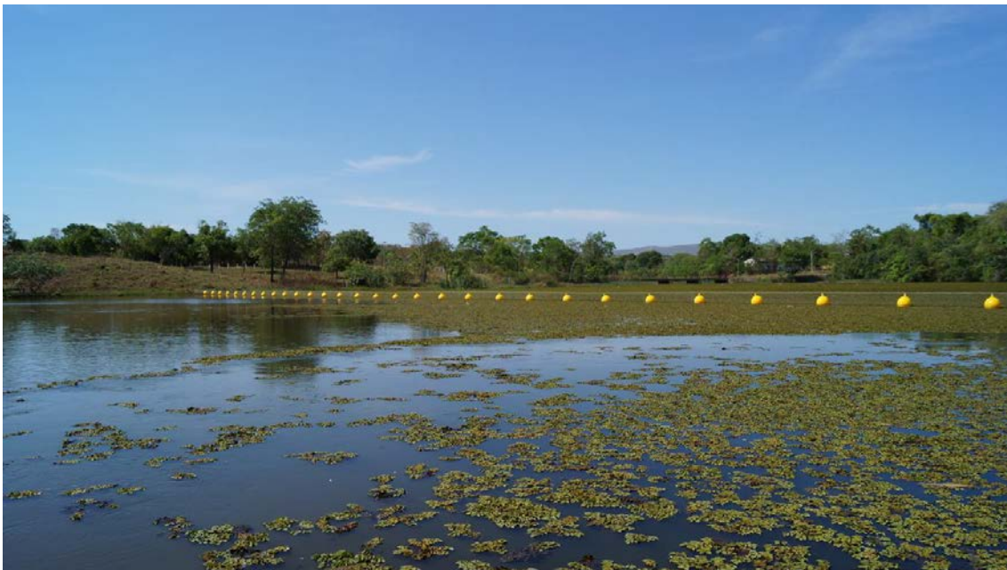
Figura 06: Vista geral da primeira contenção do rio Bonito, na direção da margem direita.
