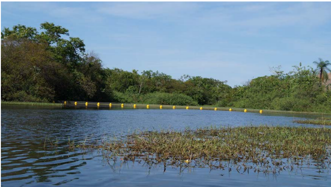
Figura 12: Detalhe da contenção instalada no córrego Amianto.
