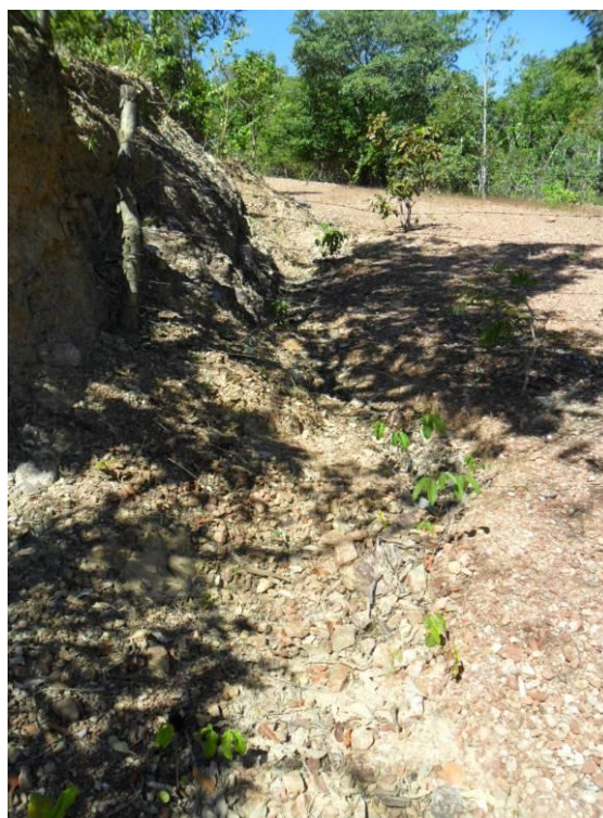
Foto 7.1.3-10 – Ponto SS5. (A) Estrada que vai até o local da balsa. (B) Ravinamento causado pelo escoamento superficial pluvial.
