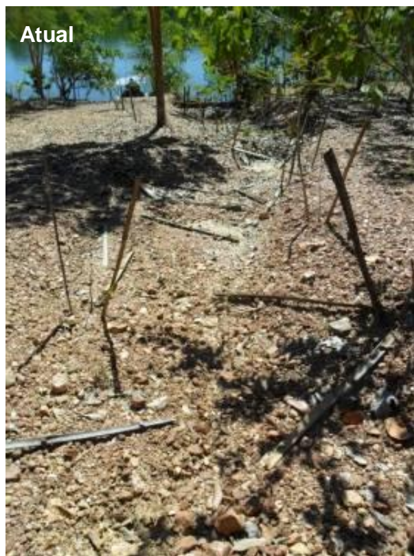
Foto 7.1.3-12 – Ponto SS5. Foto de fevereiro de 2012 e foto atual. Nota-se que houve uma recuperação desta ravina, com plantio de vegetação e construção de barreiras para diminuir a velocidade do escoamento das águas superficiais pluviais.
