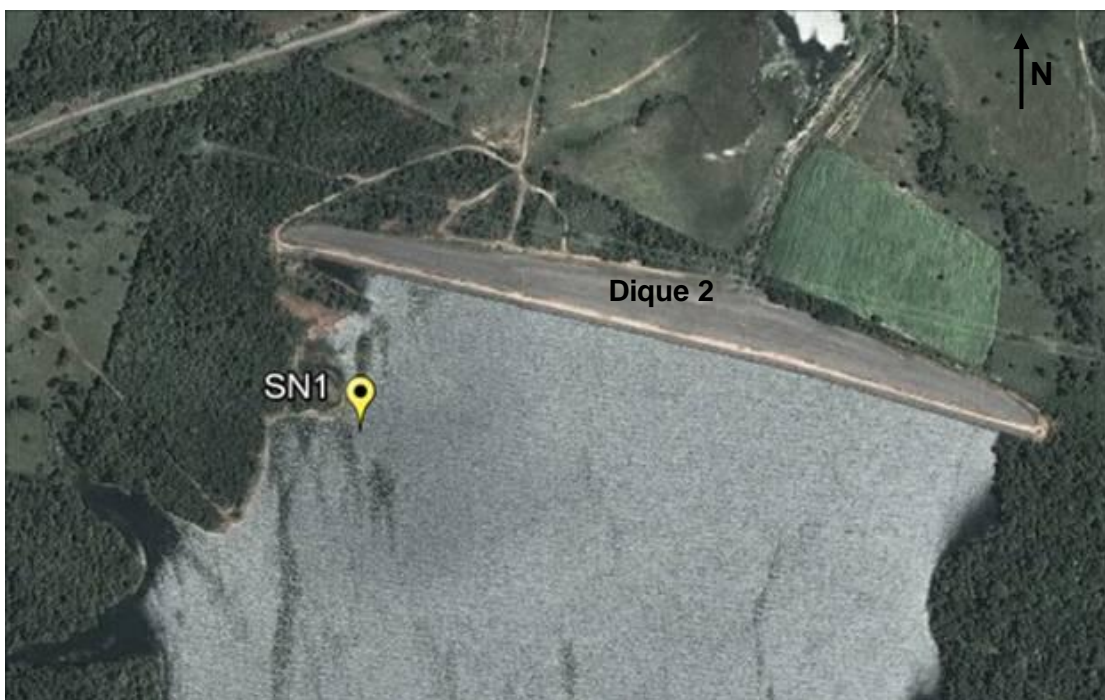
Figura 7.2.2-1 – Imagem em detalhe da localização do Ponto SN1, próximo ao Dique 2 (Imagem Google Earth, 2013, sem escala).
