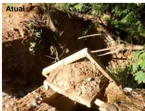
Foto 7.1.1-4 – Ponto C3 (Antigo Ponto H). Erosão na galeria pluvial da Av. Pernambuco, na Vila de Furnas. Nota-se que houve um aumento da erosão que destruiu a calçada e já atingiu a via asfaltada (destaque em vermelho).
