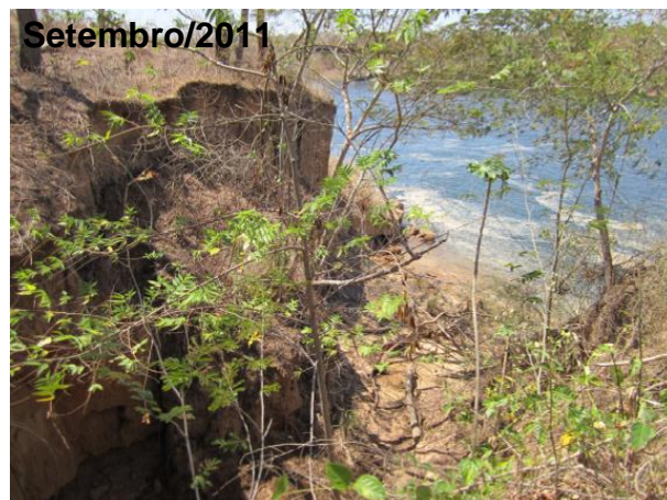
Foto 7.2.5-6 – Ponto JB2. Neste local ocorre erosão devido a uma vala de drenagem na superfície do talude causado pelo escoamento das águas pluviais (setas vermelhas). Este escoamento concentrado e com maior energia em períodos chuvosos desencadeou esta enorme erosão.
