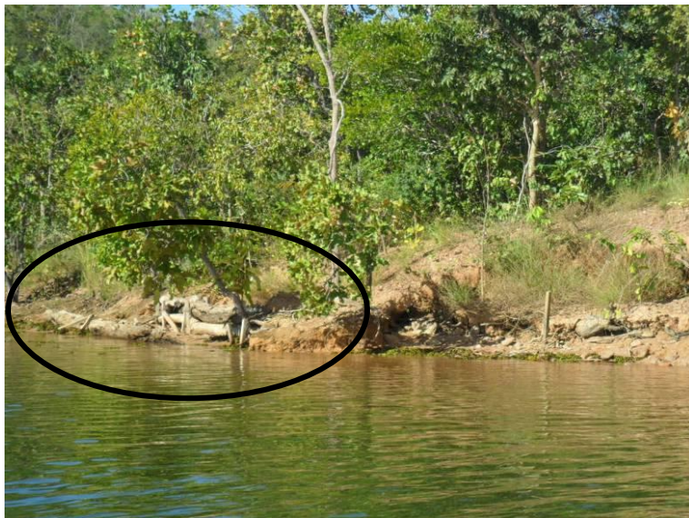
Foto 7.2.2-12 – Ponto SN7. Tentativa de conter a erosão com paliçadas de madeira.
