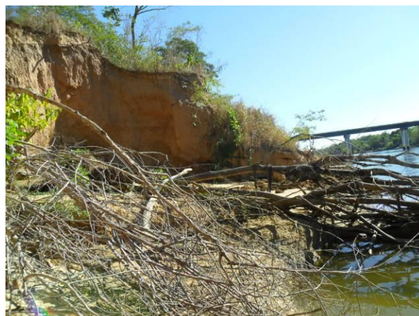
Foto 7.2.5-5 – Ponto JB2. Foto de detalhe do processo erosivo. Nota-se para as árvores caídas, que com o solapamento de base e desestabilização da porção superior do talude, caem juntamente com o solo, não sendo suficientes para segurar o solo.
