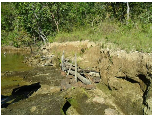
Foto 7.2.2-8 – Ponto SN5. Estruturas de paliçadas em madeira para tentar conter o processo erosivo.
