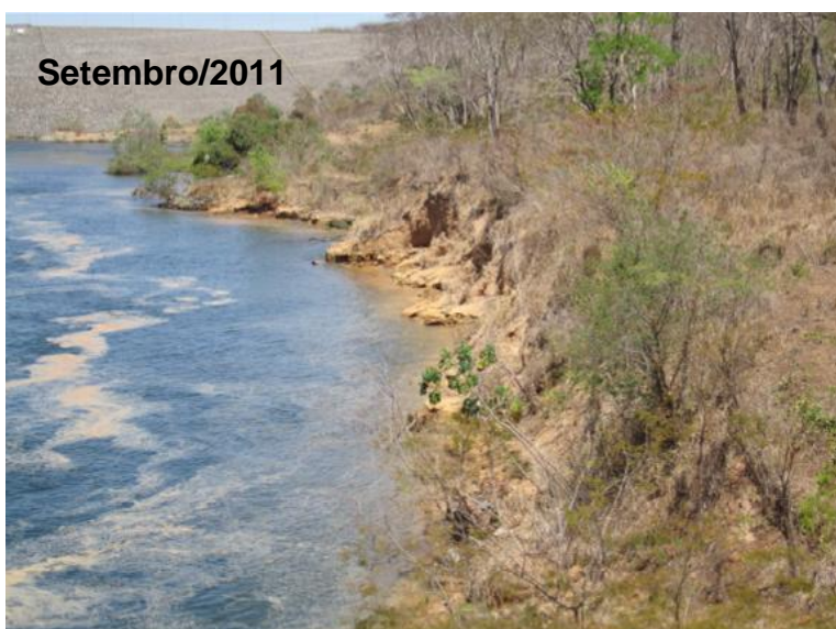
Foto 7.2.5-3 – Ponto JB2. Vista da erosão em setembro de 2011, localizada na margem esquerda do rio Tocantins.
