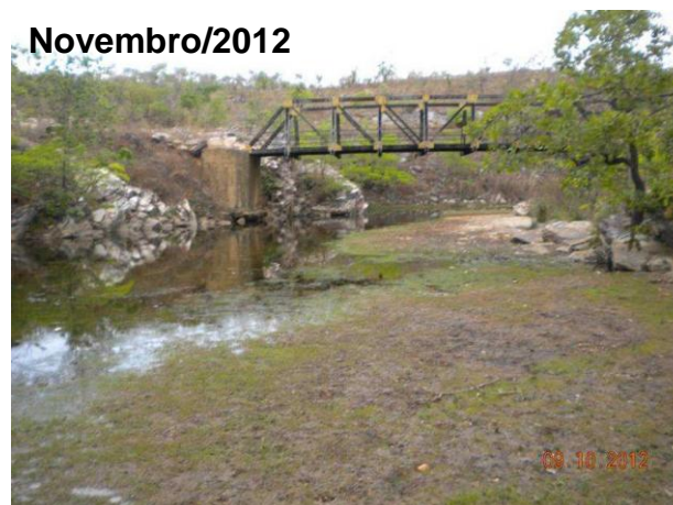
Foto 7.2.1-2 – Ponto SC6 (antigo Ponto 19). Refere-se a deposição em forma de leque de sedimentos na foz do rio dos Macacos vindos a montante deste, que deságua diretamente no reservatório. Nota-se para a evolução deste depósito. A foto de fevereiro de 2012 mostra o reservatório cheio, no qual encobre o banco de areia. Já em novembro de 2012 e junho de 2013 tem-se o banco de areia à mostra, devido ao NA baixo.
