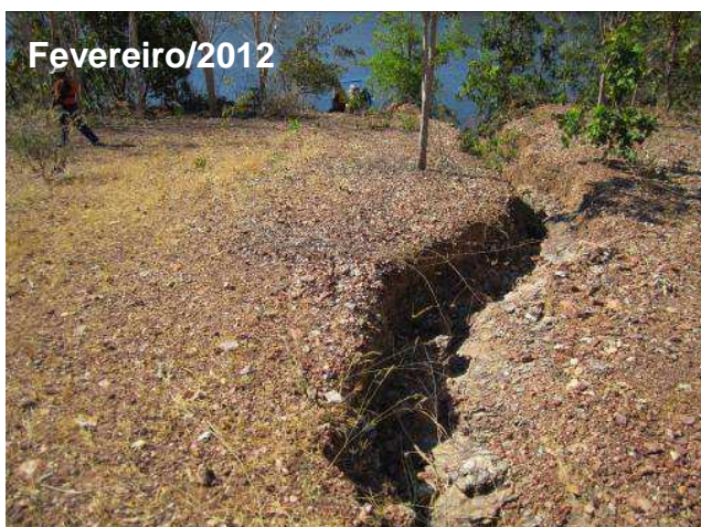
Foto 7.1.3-12 – Ponto SS5. Foto de fevereiro de 2012 e foto atual. Nota-se que houve uma recuperação desta ravina, com plantio de vegetação e construção de barreiras para diminuir a velocidade do escoamento das águas superficiais pluviais.
