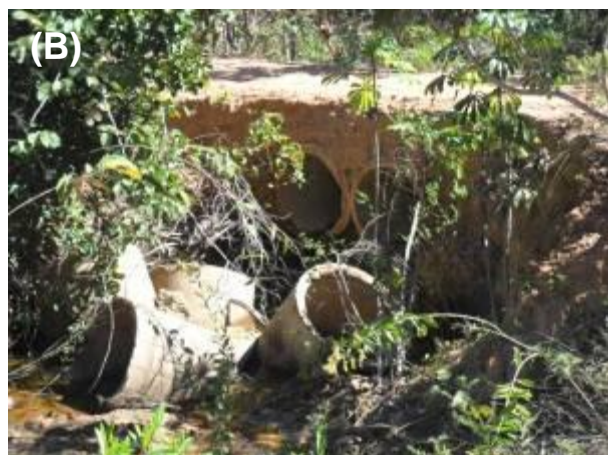
Foto 7.1.3-2 – Ponto SS3 (antigo Ponto 26). (A) Área com intensos processos erosivos, ao lado da estrada; (B) Detalhe das estruturas de drenagens, inadequadas e deterioradas, a jusante do aterramento da estrada.
