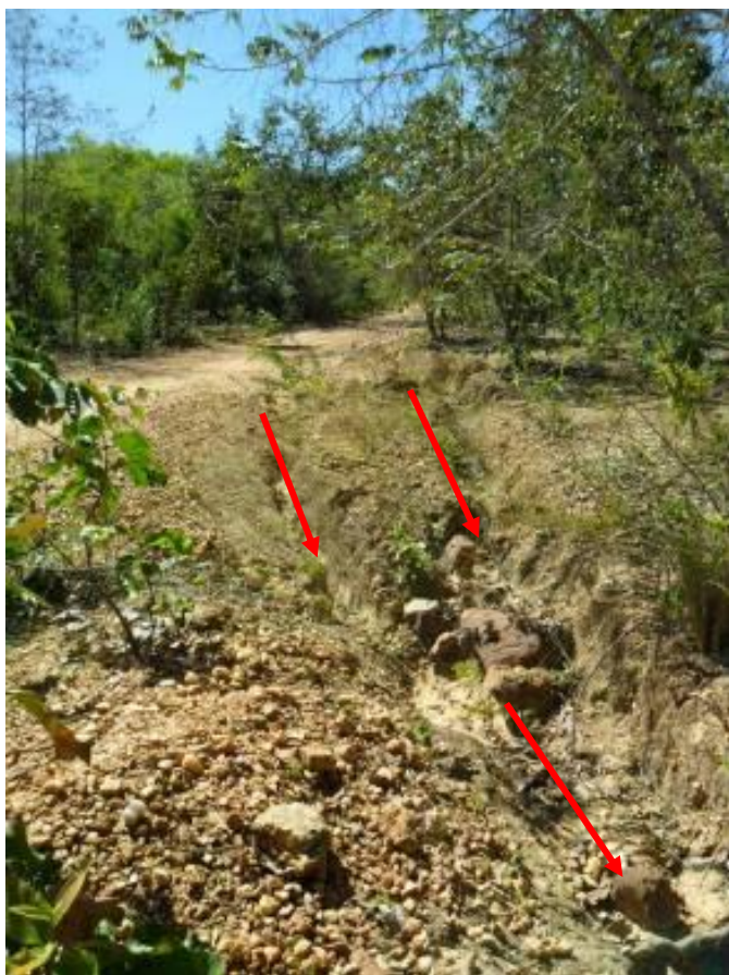
Foto 7.1.3-3 – Ponto SS3. Detalhe de um dos locais do Ponto SS3 referente às erosões em forma de ravinas ao lado da estrada, intensificados em períodos chuvosos pelo escoamento superficial das águas pluviais.
