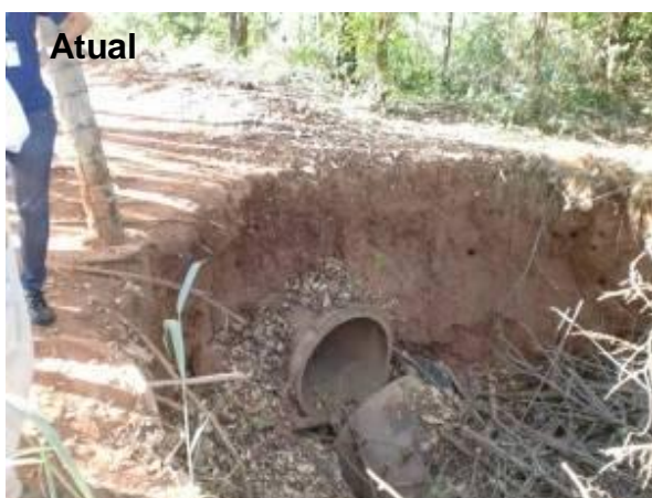
Foto 7.1.1-1 – Ponto C1 (antigo Ponto 3). Cabeceira da erosão na margem esquerda do rio Bonito próximo a ETE, onde há o deságue da rede pluvial da Vila de Furnas.
