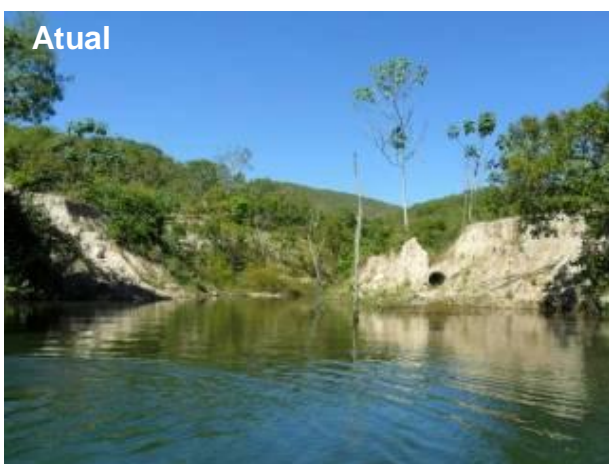
Foto 7.1.3-1 – Ponto SS2 (antigo Ponto 21). Este ponto se refere a ruptura do aterro de uma estrada, causada pela baixa capacidade de vazão dos bueiros que provocou a erosão dos taludes e assoreamento no reservatório. De acordo com as fotos temporais não foi identificado nenhuma evolução em termos de erosão, e sim de aumento de vegetação.
