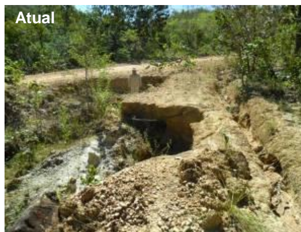
Foto 7.1.3-4 – Ponto SS3. Erosão nas imediações da estrada próxima a margem do reservatório. Nota-se sua profundidade, com aproximadamente 1 metro, e os sulcos causados pelo escoamento superficial das águas pluviais. Houve um aumento desta erosão desde maio de 2011.
