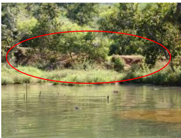
Foto 7.1.3-6 – Ponto SS4 (antigo Ponto 31). Vista geral da erosão, que causa assoreamento pontual no reservatório.
