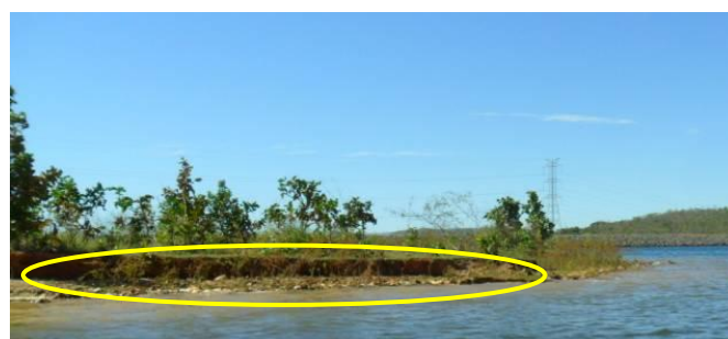
Foto 7.2.2-1 – Ponto SN1 - Próximo ao dique 2, com erosão por embate de ondas.
