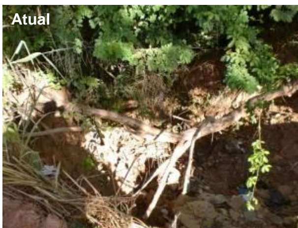
Foto 7.1.1-4 – Ponto C3 (Antigo Ponto H). Erosão na galeria pluvial da Av. Pernambuco, na Vila de Furnas. Nota-se que houve um aumento da erosão que destruiu a calçada e já atingiu a via asfaltada (destaque em vermelho).
