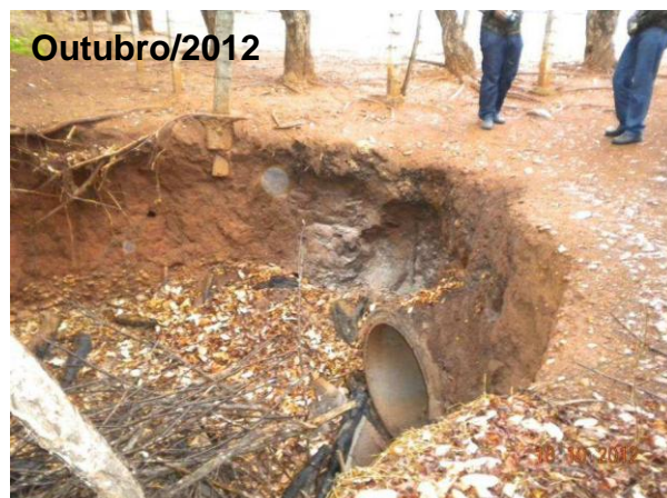
Foto 7.1.1-1 – Ponto C1 (antigo Ponto 3). Cabeceira da erosão na margem esquerda do rio Bonito próximo a ETE, onde há o deságue da rede pluvial da Vila de Furnas.
