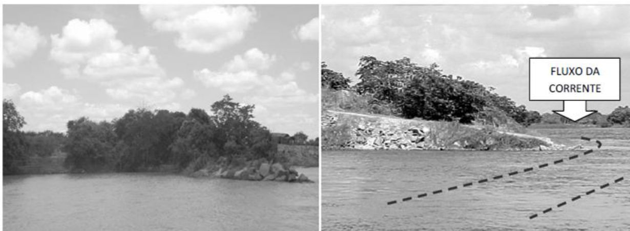
Figura 8-2 – Modelo de espigões construídos no baixo curso dos rios São Francisco e Sergipe, em março de 2007 (Holanda et al. , 2009).
