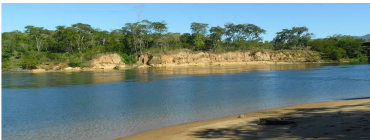
Foto 7.2.5-4 – Ponto JB2. Vista atual da erosão. Nota-se que este processo erosivo possui grande extensão, e altura de aproximadamente 6 a 7 metros.
