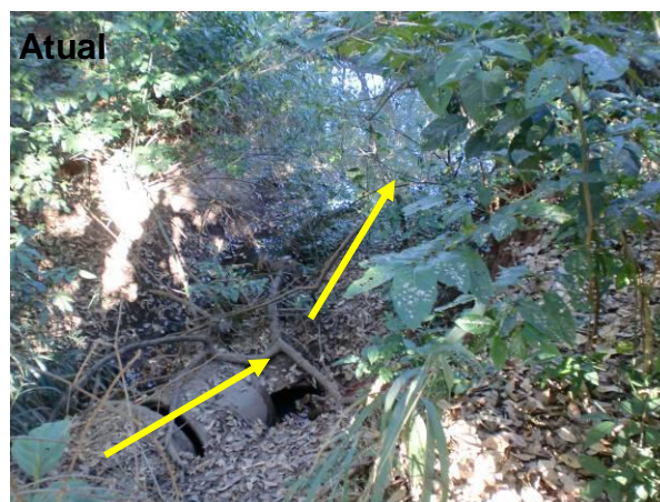
Foto 7.1.1-2 – Ponto C1 (antigo Ponto 3). Parte final da erosão, já na confluência com o rio Bonito. Nota-se que a construção da rede de drenagem pluvial não foi concluída, causando o carreamento de sedimentos para o rio (setas amarelas).
