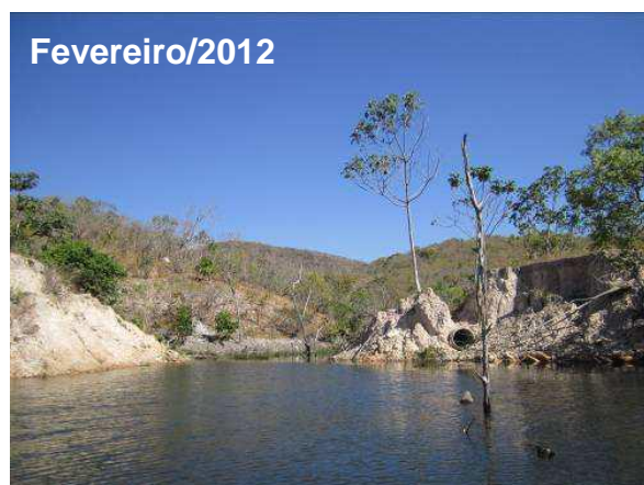
Foto 7.1.3-1 – Ponto SS2 (antigo Ponto 21). Este ponto se refere a ruptura do aterro de uma estrada, causada pela baixa capacidade de vazão dos bueiros que provocou a erosão dos taludes e assoreamento no reservatório. De acordo com as fotos temporais não foi identificado nenhuma evolução em termos de erosão, e sim de aumento de vegetação.
