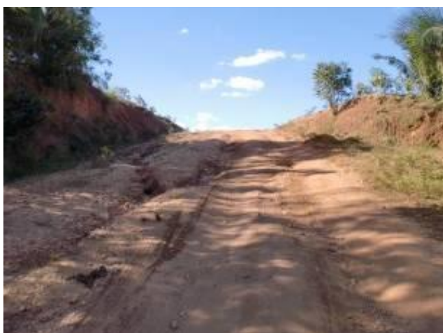
Foto 7.1.3-8 – Ponto SS4. Detalhe das erosões da Foto 7.1.3-7 que ocorrem na estrada de terra GO-132.
