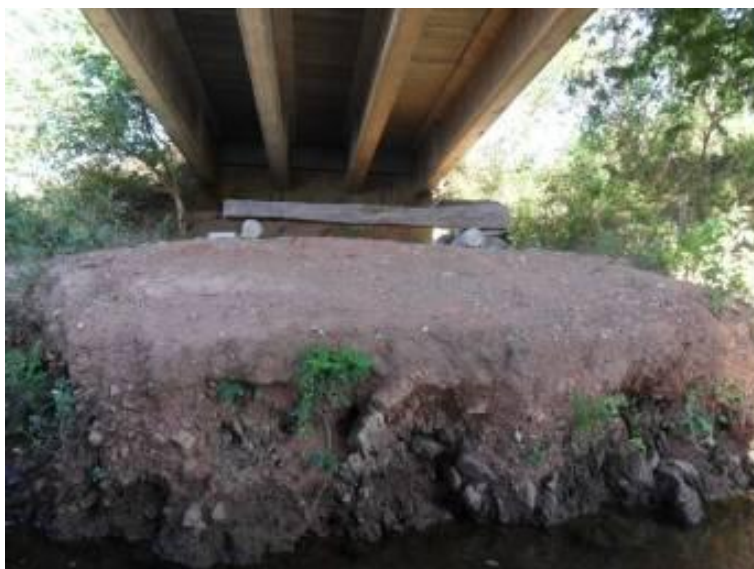
Foto 7.2.4-6 – Ponto SS7. Local da cabeceira do aterro da ponte. Nota-se que não há nenhum processo erosivo significativo.
