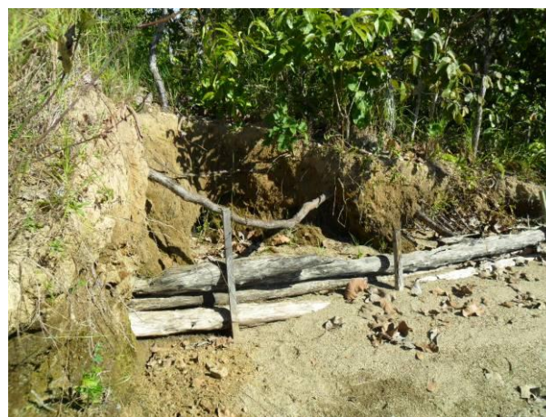
Foto 7.2.2-8 – Ponto SN5. Estruturas de paliçadas em madeira para tentar conter o processo erosivo.
