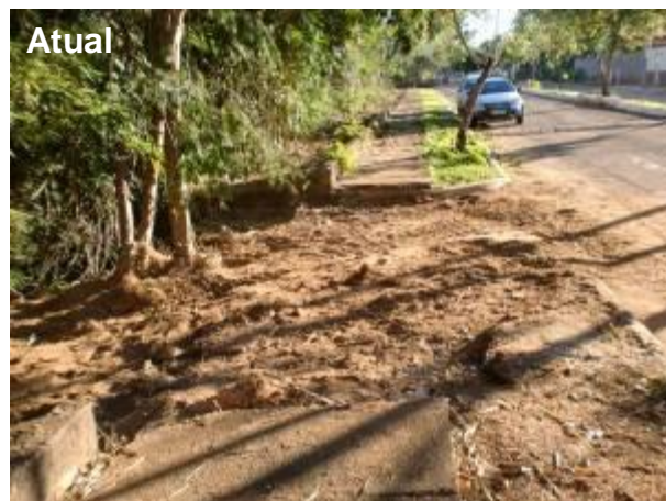
Foto 7.1.1-5 – Ponto C4 (antigo Ponto I). Localiza-se na margem esquerda do rio Bonito. Erosão em antiga galeria pluvial, com tentativa de aterramento para contenção.
