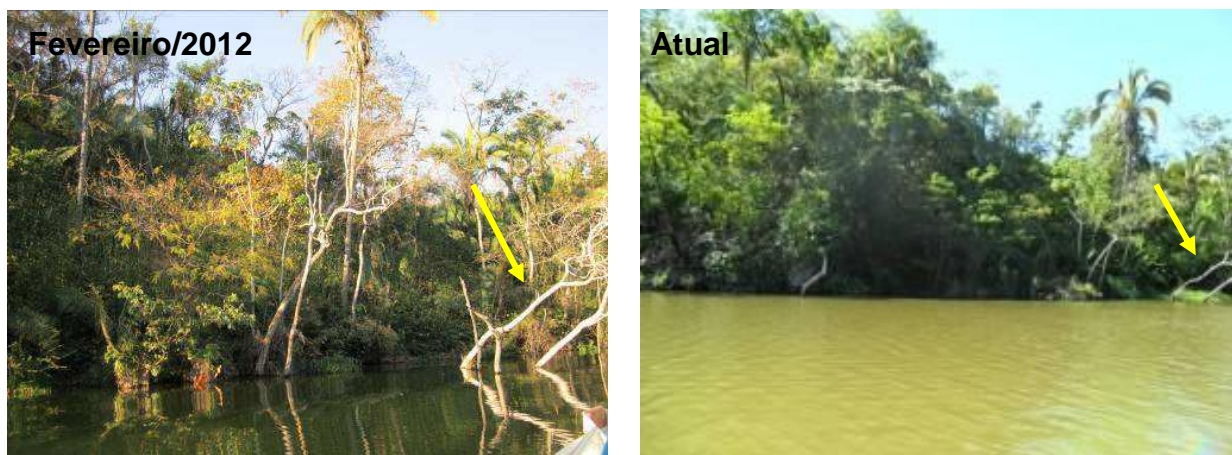
Foto 7.2.4-7 – Encosta com sinais de movimentação devido a árvores inclinadas no pé da encosta. Nota-se que não houve nenhuma movimentação aparente desde fevereiro de 2012.
