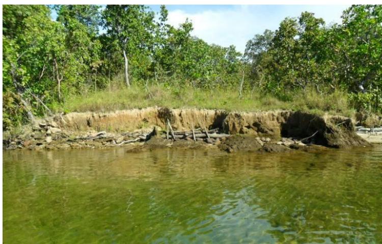
Foto 7.2.2-6 – Ponto SN5. Vista do processo erosivo localizado na Ilha 75, por embate de ondas.
