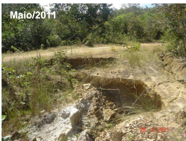
Foto 7.1.3-4 – Ponto SS3. Erosão nas imediações da estrada próxima a margem do reservatório. Nota-se sua profundidade, com aproximadamente 1 metro, e os sulcos causados pelo escoamento superficial das águas pluviais. Houve um aumento desta erosão desde maio de 2011.
