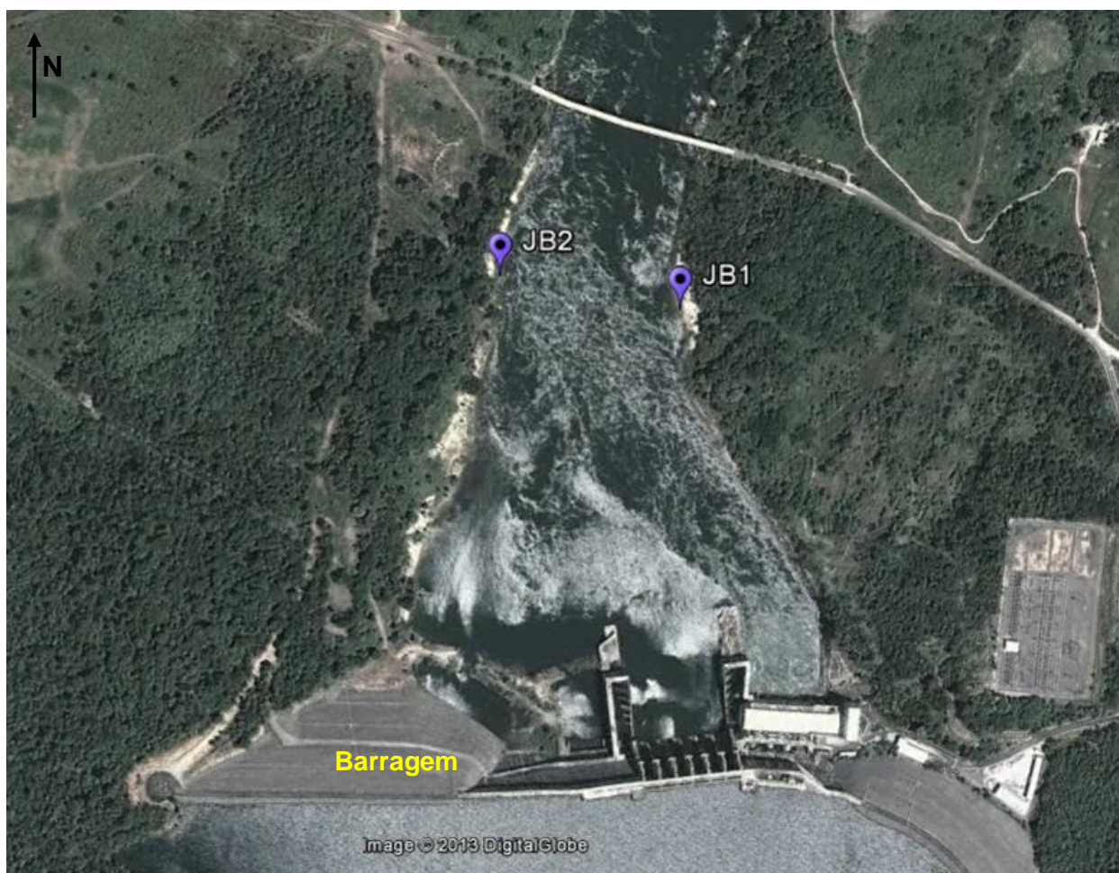
Figura 7.2.5-1 – Localizações dos pontos vistoriados a jusante da barragem da UHE Cana Brava, no rio Tocantins (Imagem Google Earth, 2013, sem escala).
