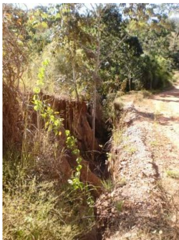
Foto 7.1.3-8 – Ponto SS4. Detalhe das erosões da Foto 7.1.3-7 que ocorrem na estrada de terra GO-132.
