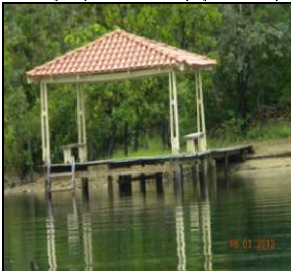
Vistoria complementar Trapiche na cota de inundação.
