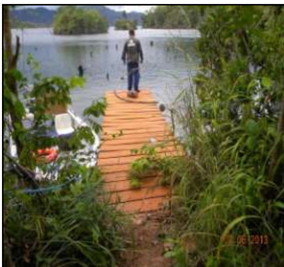
Vistoria Complementar Trapiche fixo de madeira
