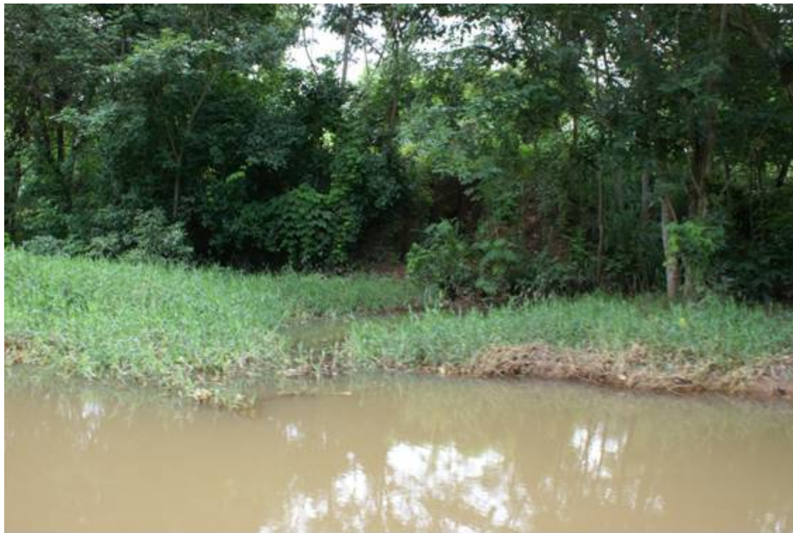
Figura 15: Vista do emissário da ETE de Furnas, em 24 de março de 2009, e o lançamento de água enegrecida ao longo da região marginal do reservatório.
