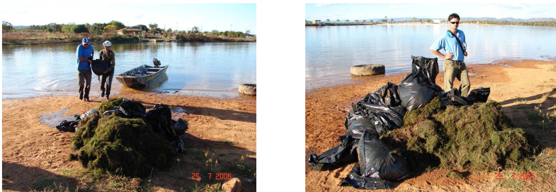
Figura 51: Vista da quantidade de plantas retiradas e ensacadas para serem encaminhadas ao aterro sanitário.
