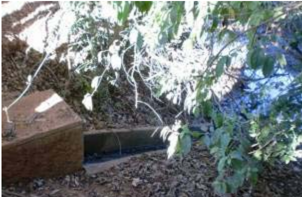
a) Ponto 3 - Lançamento do efluente tratado pela ETE da Vila de Furnas.
