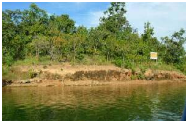
e) Ponto 6 – Processo erosivo pelo embate das ondas na MD do rio Bonito, na Ilha 75.
