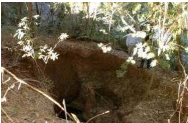
c) Ponto I – ME do rio Bonito. Erosão em área urbana.
