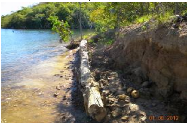
g) Monitoramento de taludes (RO-08)
