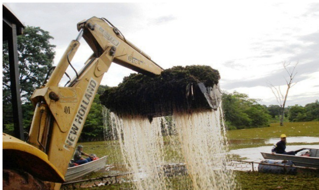
a) Retirada das macrófitas no Rio Bonito Fonte: Tractebel Energia
