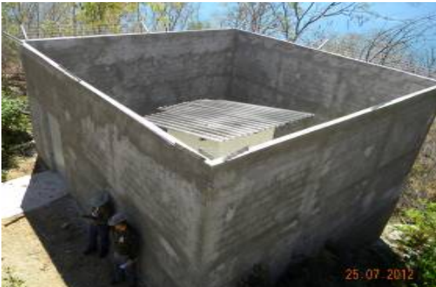
a) Vistoria na Estação Sismológica (RE-02)
