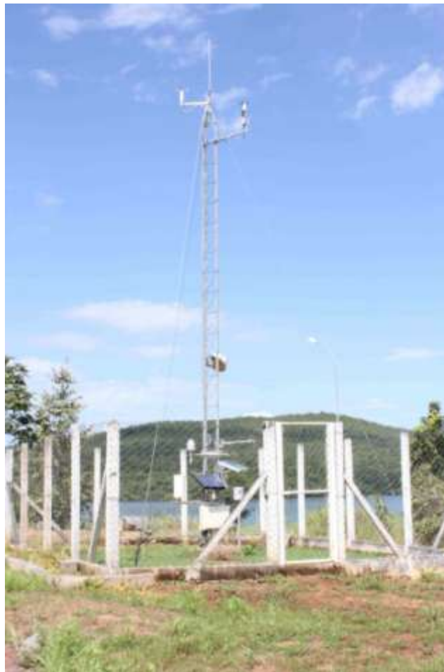
Estação meteorológica automática instalada no sítio da UHE – Cana Brava
